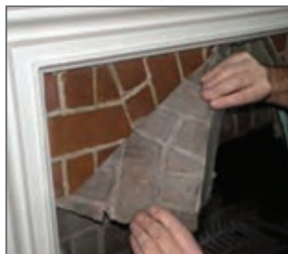
شکل ۲۱- دوده‌زدایی مکانیکی به روش برچسب پاک کننده
