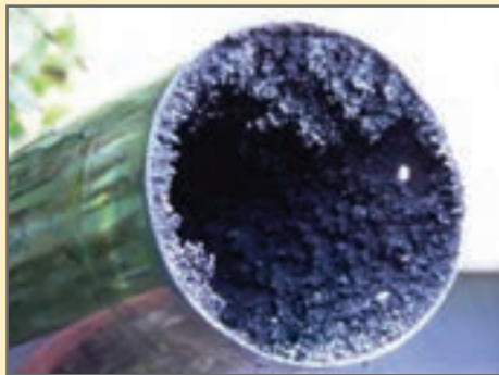
دوده ایجاد شده در داخل لوله
