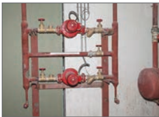
شکل ۱ - پمپ سیر کولاتور سیستم گرمایی
