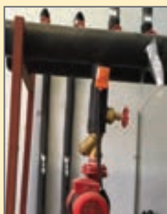
ترموستات جداری نصب روی عایق گرمایی
