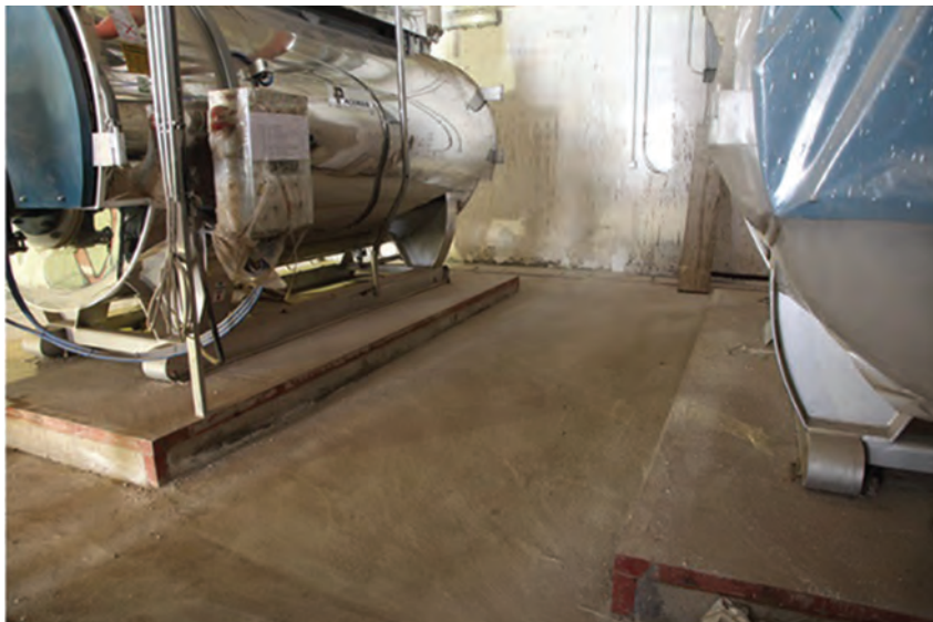
شکل ۱۴ - نصب دیگ روی فونداسیون
