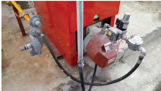
شکل ۲۹- اتصال مدار سوخت
