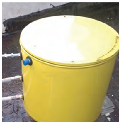
شکل ۳- مخزن انبساط باز با عایق
