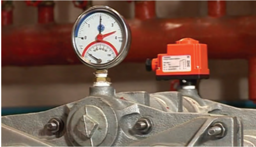
شکل ۲۱- نصب کنترل کننده و نشان دهنده دیگ
