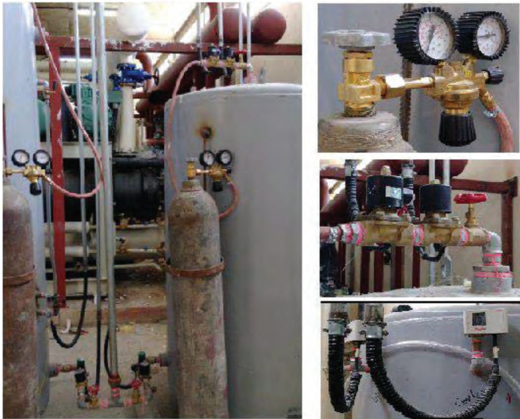
شکل ۲۳- مخزن انبساط بسته با متعلقات
