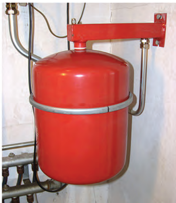
شکل ۱۶- استقرار مخزن انبساط بسته
