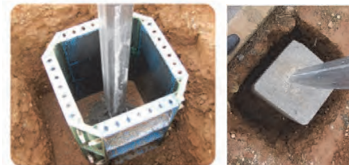
فونداسیون سازه گلخانه
