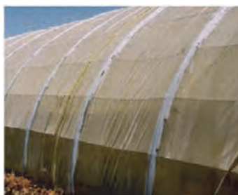
عایق‌کاری اجزا فولادی با رنگ سفید پلاستیکی
