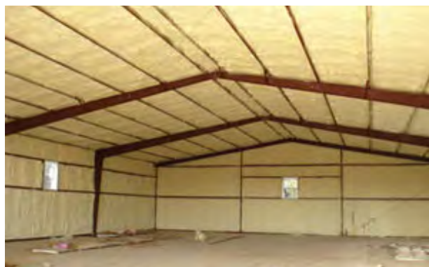
عایق‌بندی سقف و دیواره
