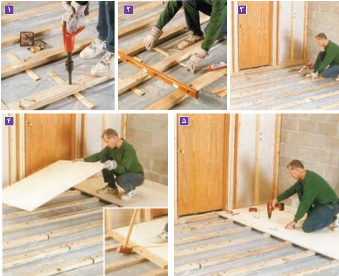
شکل ۴- مراحل نصب کف با تخته چوبی
