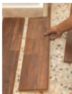
شکل ۹۰ و ۹۱ - قفل کردن قطعات لمینت به یکدیگر
