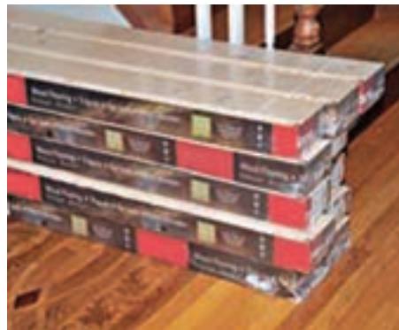
شکل ۲۸ و ۲۹- نحوه قرار دادن درست جعبه های لمینت
