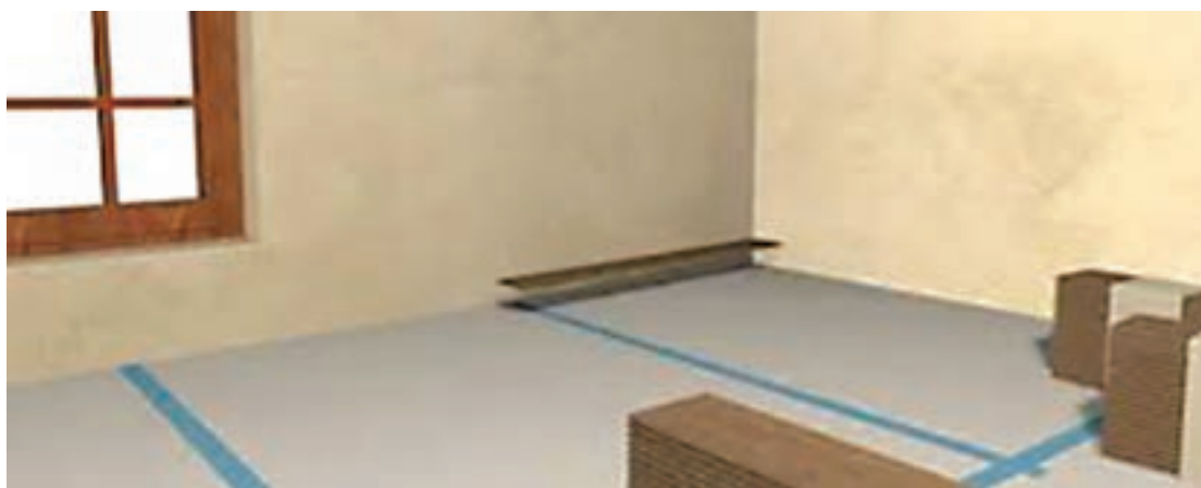
شکل ۲۴ - پوشش کامل کف با فوم صدا گیر
