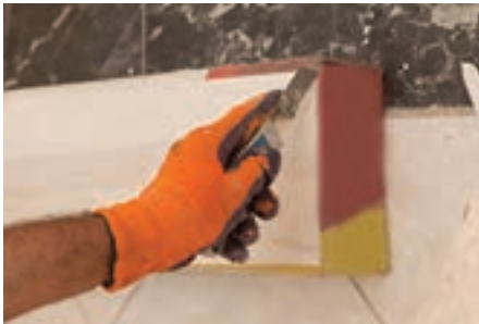
شکل ۲۸ و ۲۹- نحوه قرار دادن درست جعبه های لمینت
