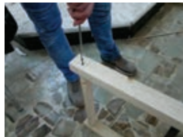
شکل ۵۶- بستن پیچ با پیچ‌گوشتی دستی
