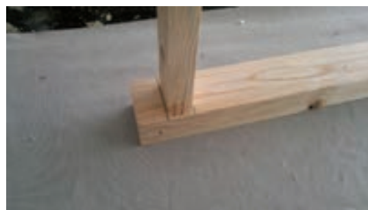
شکل ۴۹- زدن دو منگنه روی قید اول
