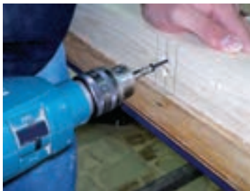
شکل ۵۸- بستن پیچ در حالت افقی
