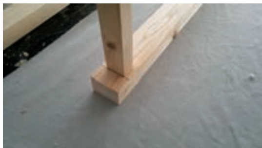
شکل ۴۷- استقرار قید افقی بر روی قید طولی
