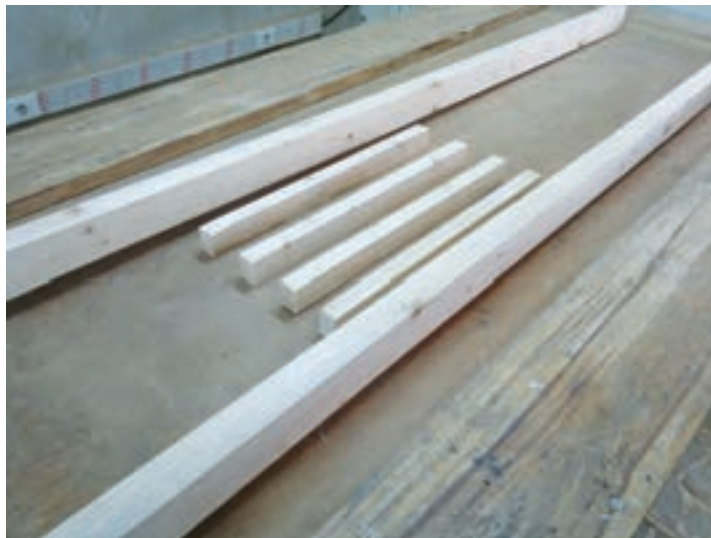
شکل ۳۹- قطعات پاراوان (۲ قید طولی و ۴ قید عرضی)
