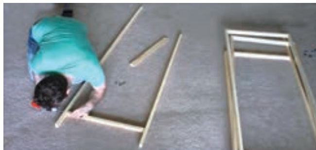
شکل ۱۹- ساخت قاب پارتیشن
