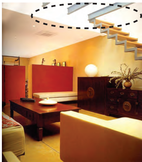
شکل ۱۰۲-۲- ایجاد حفره درون سقف (وید - void) در فضا با حفظ تیرهای باربر سقف
