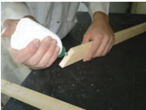
شکل ۲۴-چسب زدن سر قطعات
