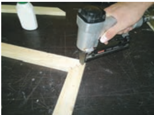
شکل ۲۶-زدن ۲ یا ۳ منگنه در گوشه قاب
