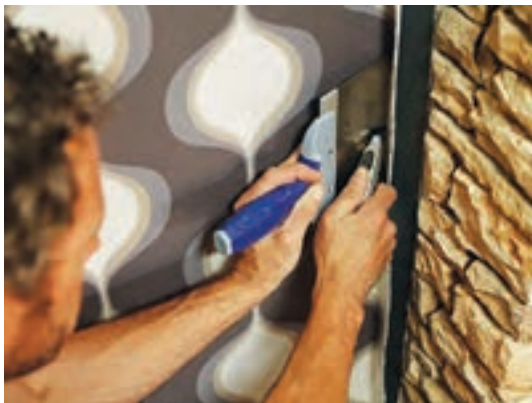
شکل ۸۵- برش اضافه پارچه روی دیوار
