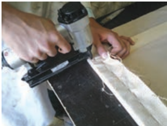
شکل ۳۴- منگنه زدن یک گوشه دیگر از قاب
