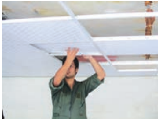
شکل ۱۷- نصب و تنظیم پنل در شبکه فلزی
