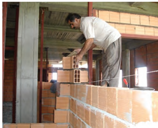
شکل ۱-۴- ریسمان کشی جهت اجرای مستقیم دیوار
