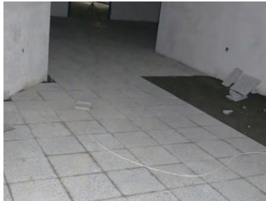
شکل ۲۷-۴- اجرای کف موزائیک در داخل ساختمان
