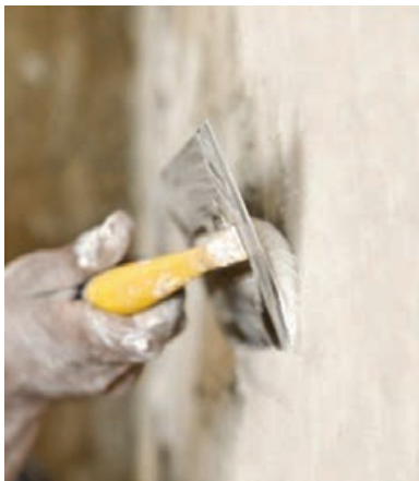
شکل ۱۶-۴- جزئیات نحوه ماله‌کشی و شمشه‌گیری اندود گچی دیوار
