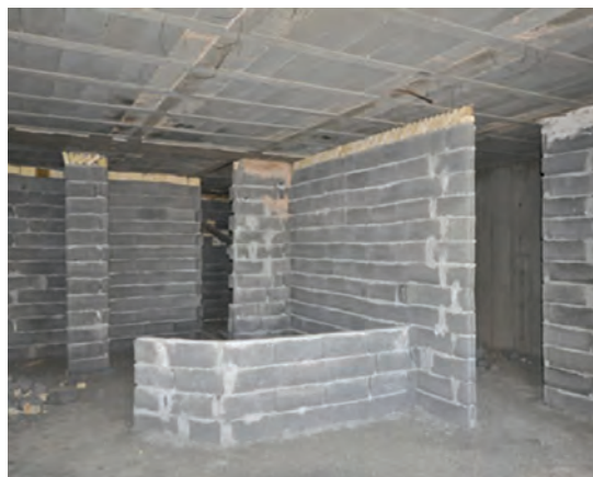
شکل ۴-۷- اجرای دیوار داخلی با بلوک لیکا (بلوک سیمانی سبک با خاک رس منبسط شده)
