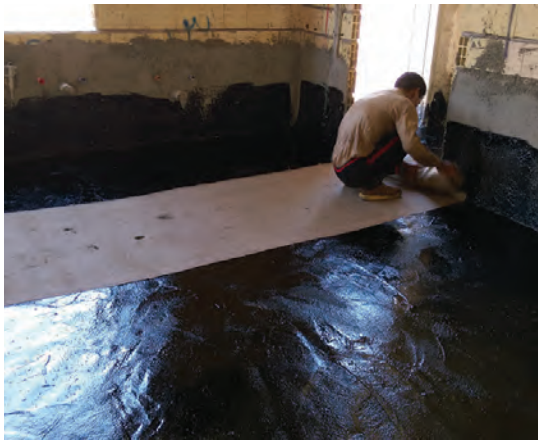
شکل ۱۱-۴- اجرای قیرگونی کف فضای داخلی
