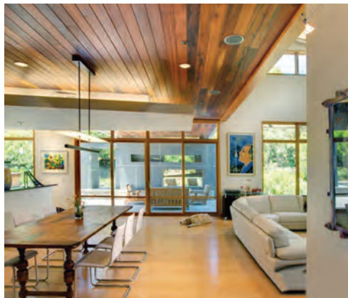
شکل ۲۵-۴- سقف لمبه کوبی شده چوبی
