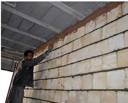
شکل ۲-۴- اجرای دیوار چینی با بلوک سفالی
