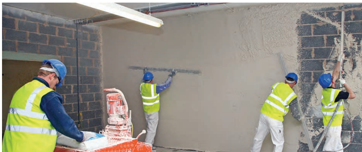
شکل ۱۷-۴- اندود گچ سفیدکاری روی دیوارهای داخلی
