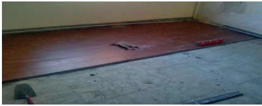
شکل ۲۸-۴- اجرای کف پوش لمینت
