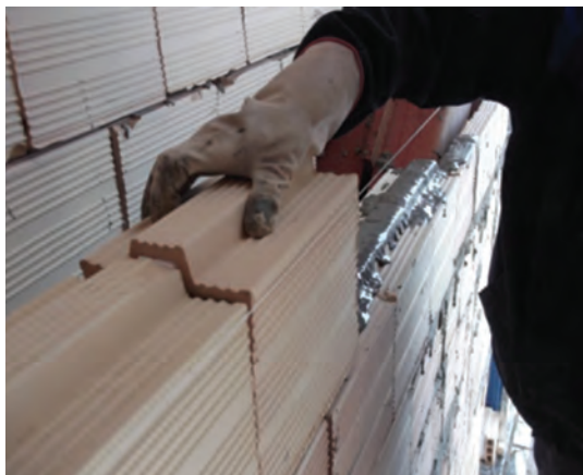
شکل ۴-۵- اجرای بلوک سفالی در امتداد ریسمان
