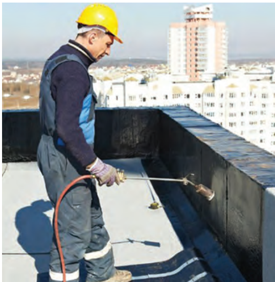
شکل ۱۳-۴- اجرای ایزولاسیون پیش ساخته بر روی دیوار جان پناه بام
