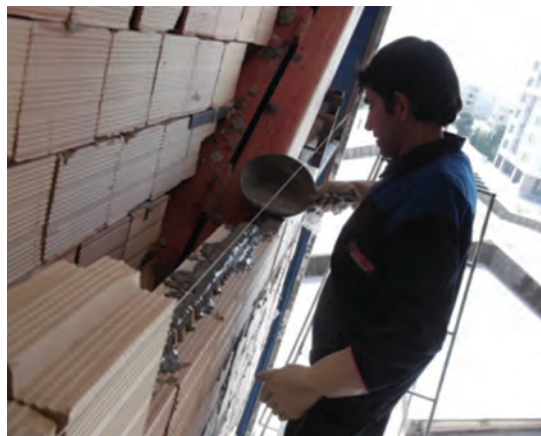
شکل ۴-۶- ملات ماسه سیمان جهت اتصال بلوکها
