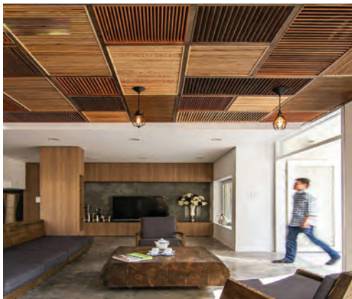
شکل ۲۶-۴- تزئینات سقف کاذب چوبی
