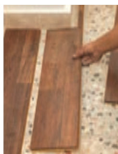
شکل ۹۰ و ۹۱ - قفل کردن قطعات لمینت به یکدیگر
