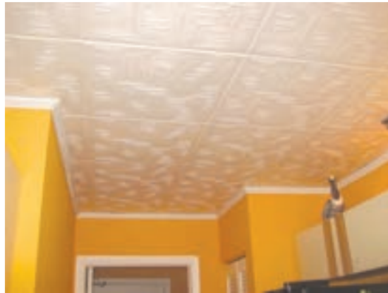
شکل ۳- اجرای سقف کاذب با فوم
