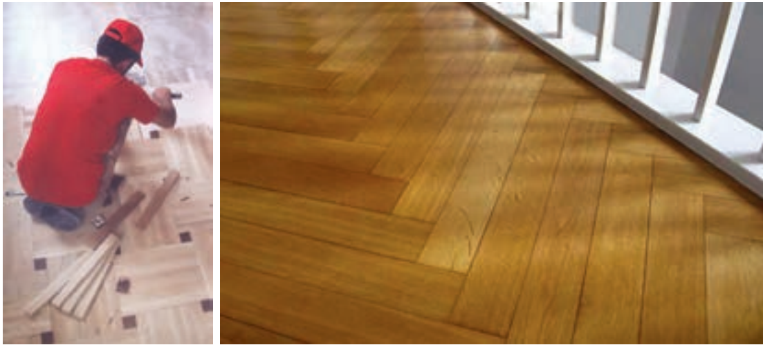
شکل ۷ و ۸- نمونه‌هایی از کف‌سازی با بلوک‌های چوبی
