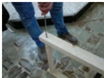
شکل ۵۶- بستن پیچ با پیچ‌گوشتی دستی
