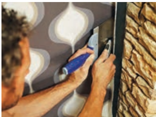
شکل ۸۵- برش اضافه پارچه روی دیوار
