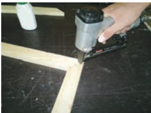
شکل ۲۶-زدن ۲ یا ۳ منگنه در گوشه قاب
