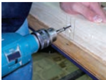
شکل ۵۸- بستن پیچ در حالت افقی
