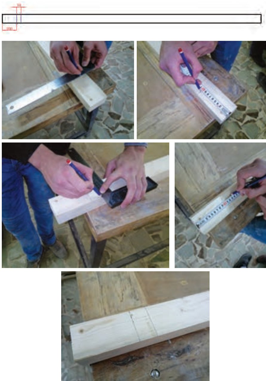
شکل ۴۰- اندازه گیری و خط کشی محل نصب قید پایین پاراوان
