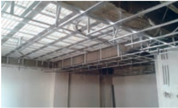
شکل ۱۶- بررسی تأسیسات و محل عبور سیم برق
