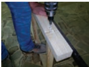
شکل ۵۴- سوراخ کاری جای پیچ دوم
