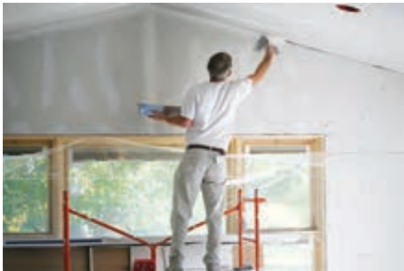
شکل ۱۸- پرداخت درز بین دیوار و سقف کاذب
