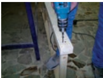
شکل ۵۷- بستن پیچ با دریل
