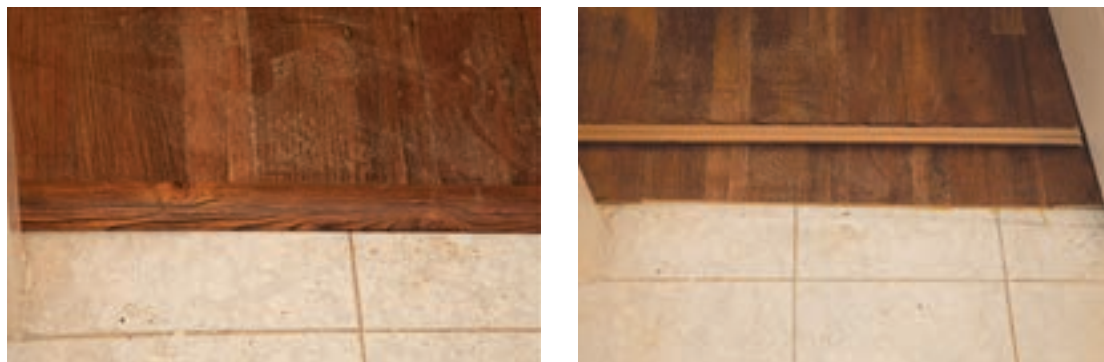
شکل ۸۲ و ۸۳ - پشت و روی پروفیل آستانه
