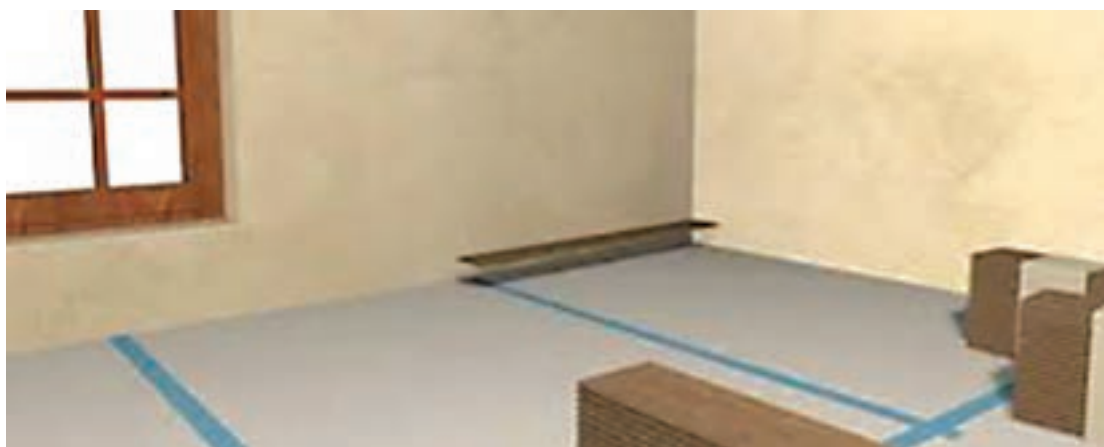
شکل ۲۴ - پوشش کامل کف با فوم صدا گیر
