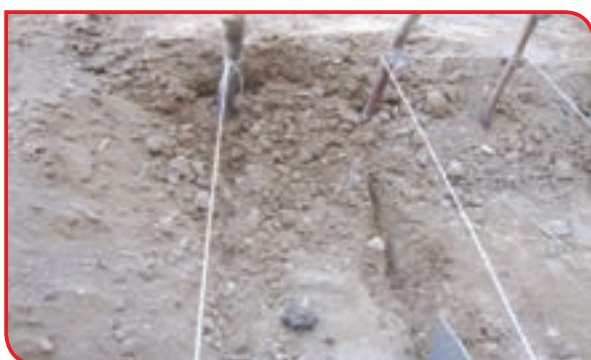
۶- ایجاد شیار (شکاف) در زیر نخها
