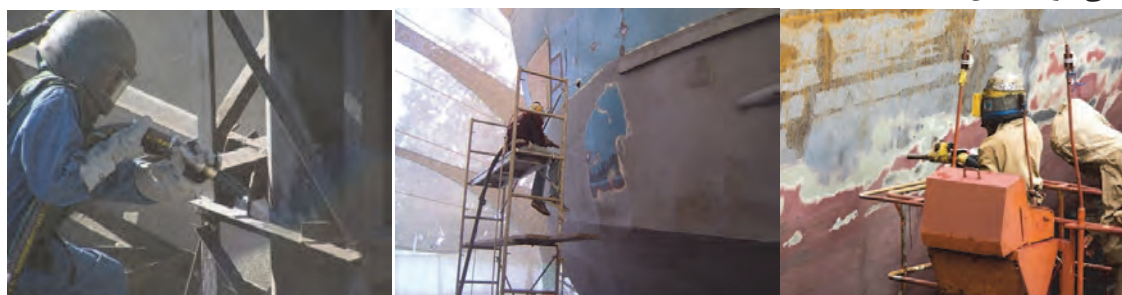
شکل ۱-۷ زنگ‌زدایی در اسکله خشک
