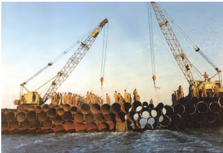
شکل ۱۱-۵- پل بعثت در حال ساخت
