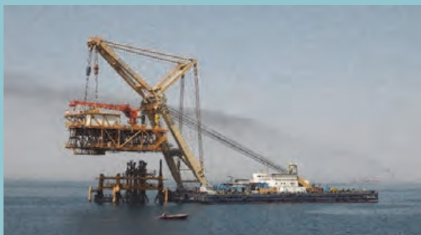
عملیات نصب سکوی فرآورش لایه نفتی پارس جنوبی به وسیله شناور جرثقیل‌دار صدف ۳۰۰۰
