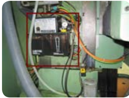
مکان نصب مخزن واحد مرکزی
