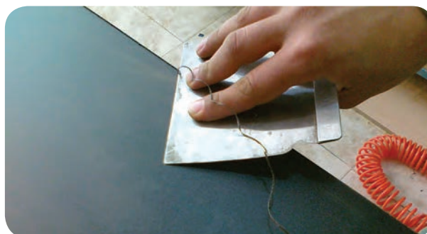
شکل ۲۵-۴ - نحوه برطرف کردن اضافه نوار با لیسسه
