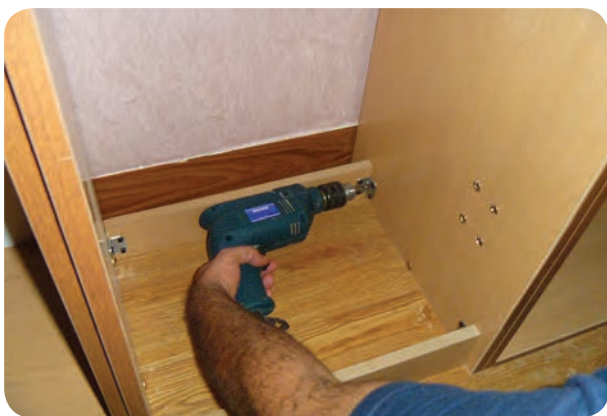
شکل ۱۸۰-۵- نصب پاسنگ‌ها
