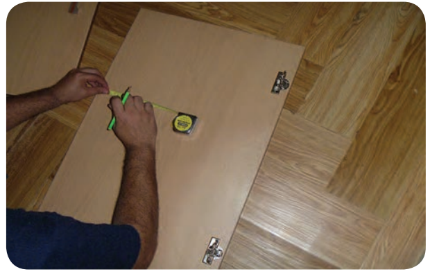
شکل ۱۵۰-۵- نصب لولای در کمد
