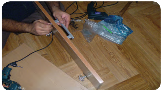
شکل ۱۵۹-۵- نصب دستگیره در کمد
