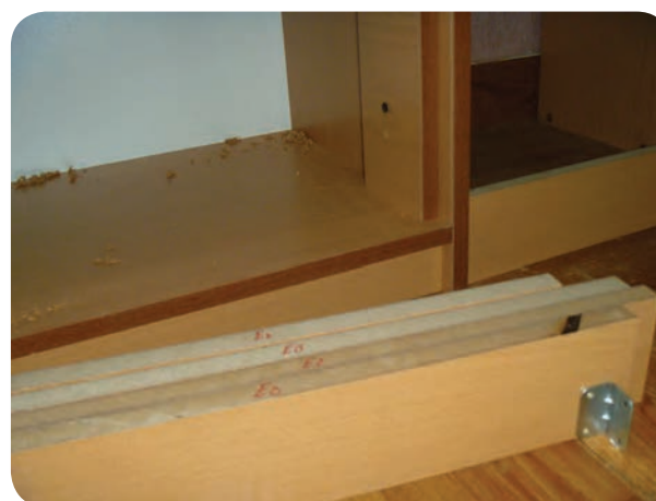
شکل ۱۶۶-۵- نصب پاسنگ با استفاده از گونیای فلزی
