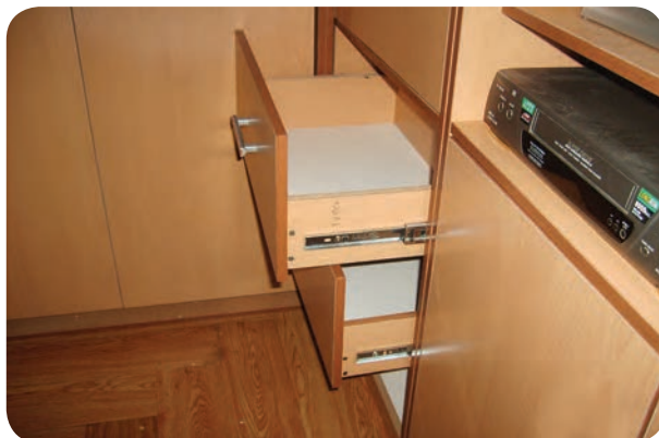
شکل ۱۷۷-۵- نصب کشویی تلسکوپی سه ريله برای کشو
