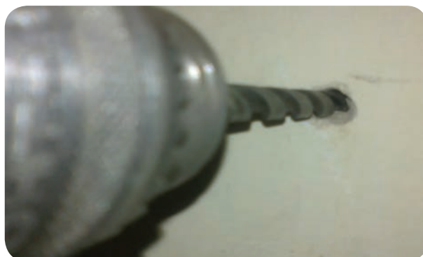
شکل ۶-۶ - سوراخکاری دیوار با مته الماسه مناسب
