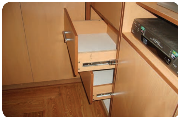
شکل ۵-۱۷۷- نصب کشویی تلسکوپی سه ریله برای کشو
