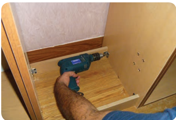
شکل ۵-۱۸۰- نصب پاسنگ‌ها
