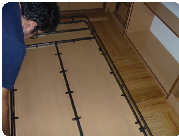
شکل ۵-۶- کفی محل استقرار تشک روی کلاف فلزی
