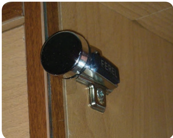
شکل ۵-۱۴۴- استفاده از واشر پلاستیکی بین کار، لولا و شیشه
