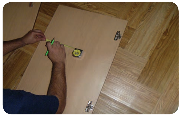
شکل ۱۵۰-۵- نصب لولای در کمد
