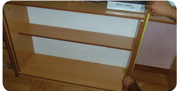
شکل ۱۷۳-۵- اندازه‌گیری برای نصب صفحه زیر کشوها
