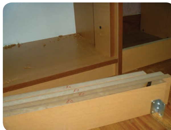
شکل ۵-۱۶۶- نصب پاسنگ با استفاده از گونیای فلزی
