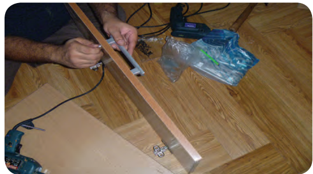
شکل ۱۵۹-۵- نصب دستگیره در کمد
