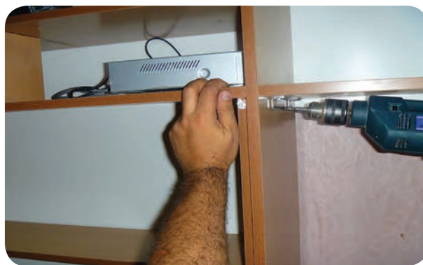
شکل ۵-۱۴۲- استفاده از اتصال گونیی فلزی در نصب طبقات
