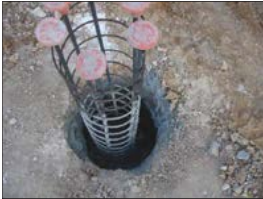
شکل ۱-۷۳ پی چاهی در حال اجرا
