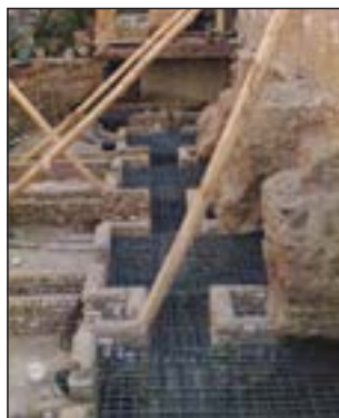
شکل ۹۰-۱ مهاربندی با شمع چوبی
