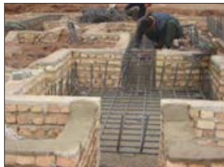
شکل ۱-۸۲ قالب‌بندی آجری در اطراف پی
