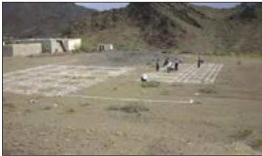
شکل ۸۳-۱ پیاده کردن نقشه روی زمین
