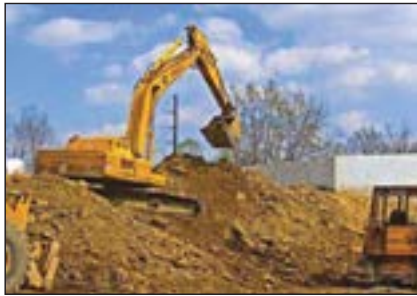
شکل ۱-۱۳- کندن زمین با وسایل مکانیکی
