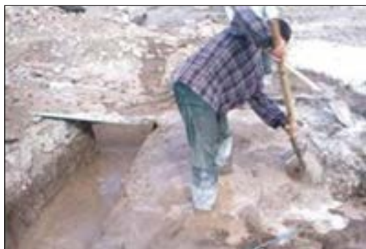
شکل ۱-۳۱ اجرای شفته آهک در فونداسیون
