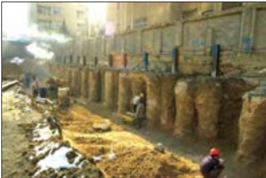
شکل ۸۸-۱ مهاربندی با پشت بند خاکی ستونی
