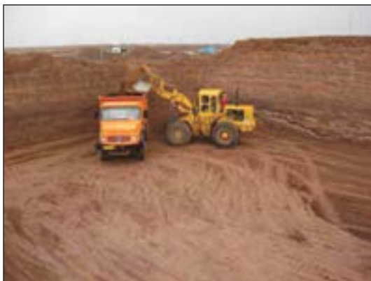
شکل ۸۵-۱ گودبرداری با لودر در زمین نامحدود
