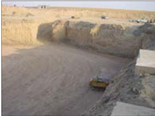
شکل ۸۴-۱ زمین گودبرداری شده
