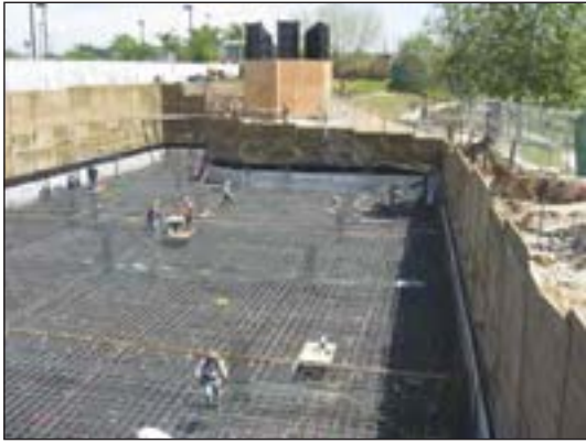
شکل ۱-۶۲ پی بتن مسلح یکپارچه (رادیه ژنرال)
