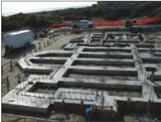
شکل ۱-۵۶ پی بتن مسلح نواری شبکه ای زیرستون
