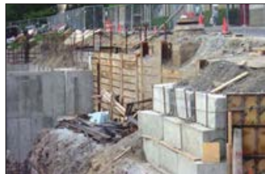
شکل ۹۱-۱ مهاربندی با دیوار مانع چوبی
