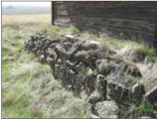
شکل ۱-۳۲ پی سنگی با سنگ لاشه
