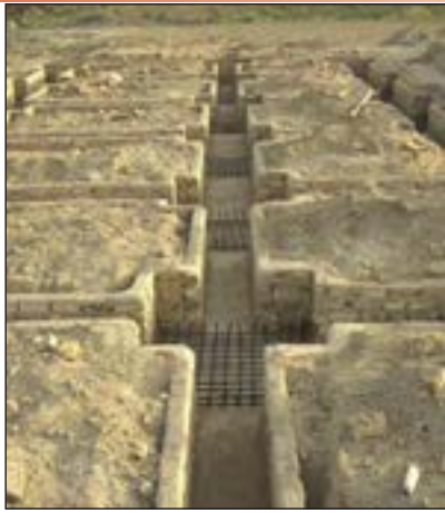
شکل ۴۸-۱ آرماتورگذاری پی تکی کلاف بندی شده
