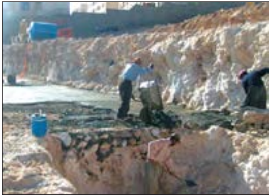
شکل ۸۷-۱ گودبرداری دستی (با بیل و کلنگ)
