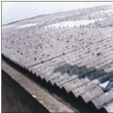
شکل ۹-۱ آزیست (سقف شیب دار)
