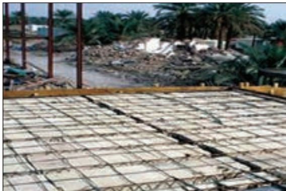
شکل ۱۳-۱ سقف تیرچه بلوک
