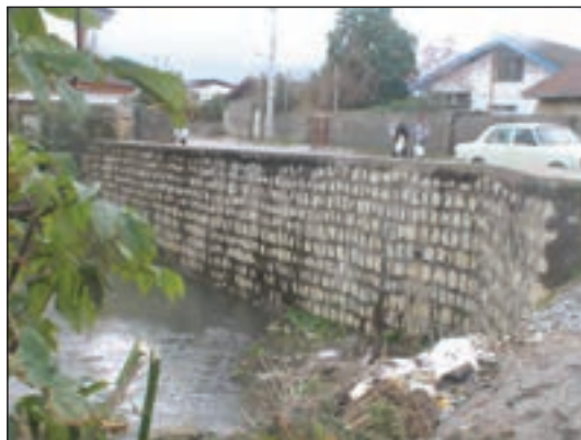
شکل ۱-۱۱۰ دیوار حائل سنگی
