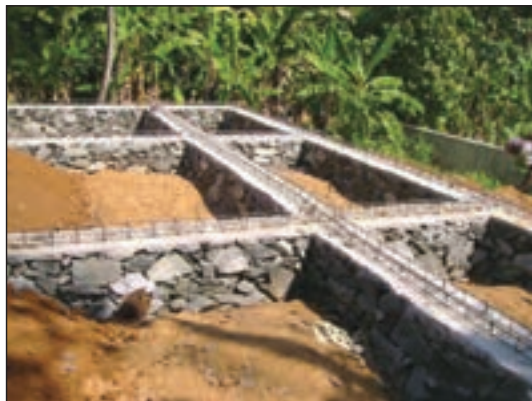
شکل ۲۰۴-۱ آرماتورگذاری داخل کلاف بندی افقی تحتانی
