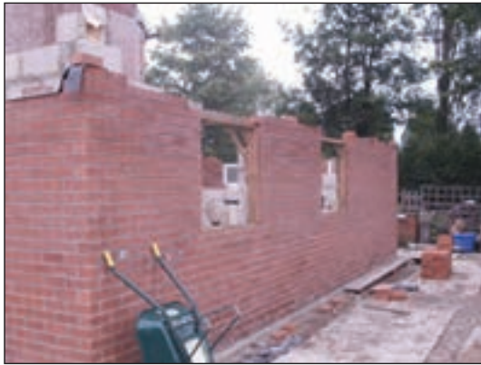
شکل ۱-۱۰۷ دیوار باربر آجری
