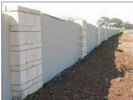
شکل ۱۳۲-۱ دیوار با ترکیب مصالح سنگ و قطعات پیش ساخته‌ی بتنی
