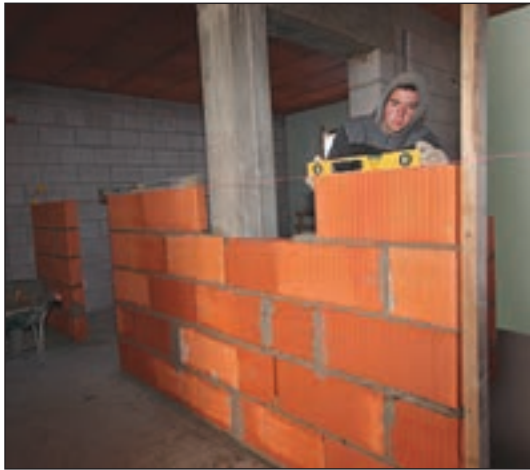
شکل ۱-۱۰۹ دیوار غیرباربر بلوک سفالی
