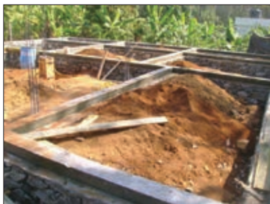
شکل ۲۰۵-۱ بتن ریزی کلاف بندی افقی تحتانی
