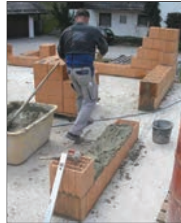
شکل ۱-۱۵۳ ساخت دیوار با بلوک سفالی
