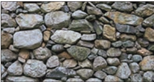
شکل ۱۳۶- دیوار سنگی خشکه چین
