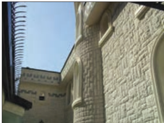
شکل ۱۳۱-۱ دیوار با مصالح سنگ بادبُر
