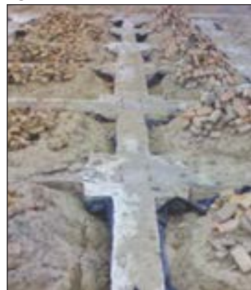
شکل ۷۳-۲ پی و شناژ بعد از بتن ریزی
