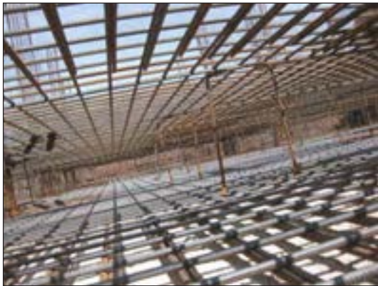
شکل ۱۲۵-۲ خرک بین دو شبکه‌ی میل‌گرد تحتانی و فوقانی از پی نواری
