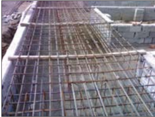
شکل ۱۴۶-۲ پی نواری و آرماتورگذاری آن
