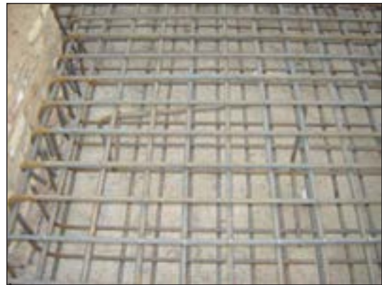
شکل ۱۴۷-۲ پی نواری و آرماتورگذاری آن
