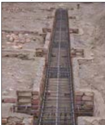
شکل ۷۲-۲ پی و شناژ قبل از بتن ریزی
