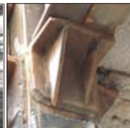
اتصال تیر به ستون به صورت لچکی
