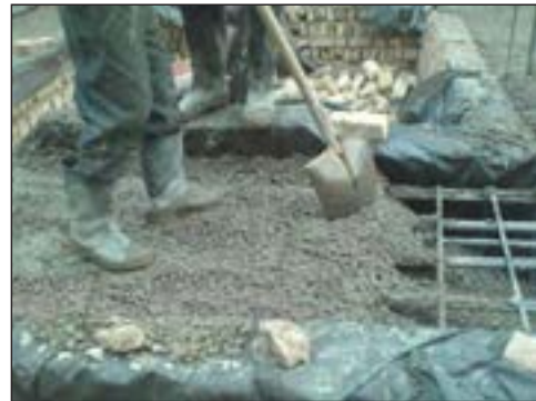
شکل ۲-۱۴۵ مرحله ی بتن ریزی داخل پی
