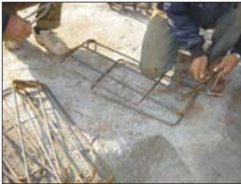
شکل ۲-۱۴۰ خم آرماتور و ساخت خاموت
