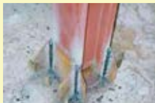
اتصال مناسب و جوش صحیح
