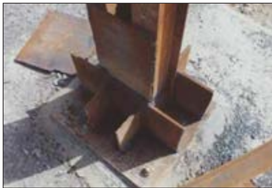
شکل ۱۶۸-۲ اتصال گیردار
