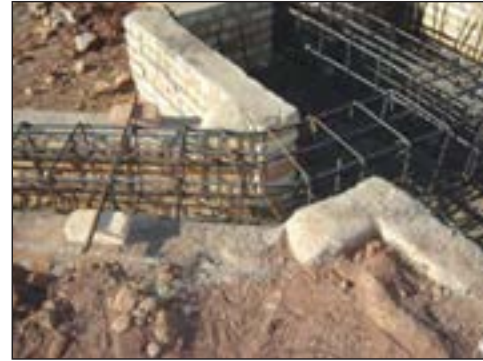
شکل ۲-۱۴۳ آرماتورهای شناژ و پی
