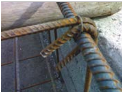
شکل ۲-۱۴۲ قلاب سرخاموت و بستن آن با مفتول
