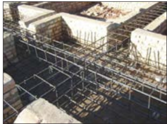
شکل ۷۱-۲ عبور میلگردهای شناژ در پی
