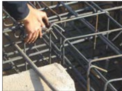
شکل ۲-۱۴۱ بستن خاموت دورآرماتور اصلی شناژ
