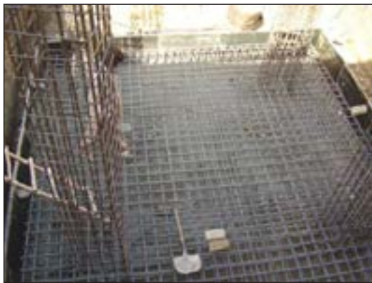
شکل ۱۵۱-۲ آرماتورگذاری پی صفحه‌ای با ستون‌های بتنی
