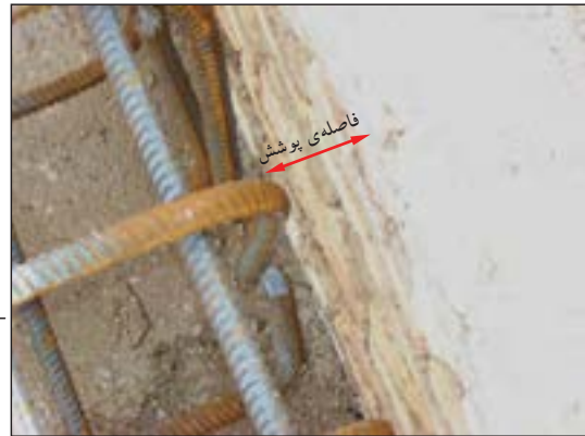
شکل ۱۲۶-۲ فاصله‌ی پوشش و قلاب سر میل‌گردها
