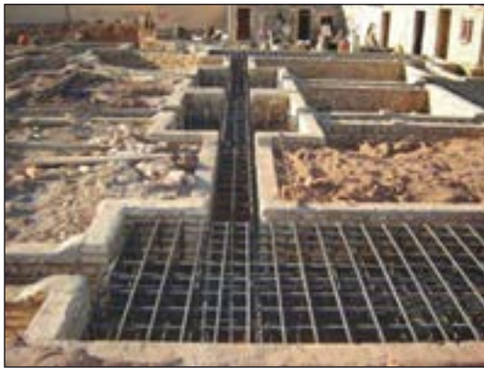
شکل ۷۰-۲ میلگردگذاری در پی کلاف بندی
