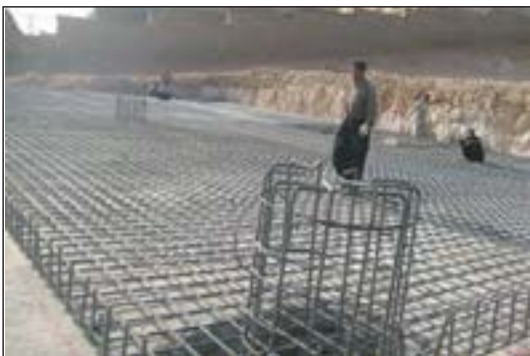
شکل ۱۵۲-۲ آرماتورگذاری پی صفحه‌ای با ستون‌های بتنی
