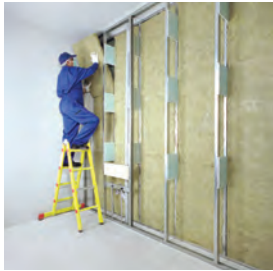
اجرای پانل ها در یک طرف دیوار
