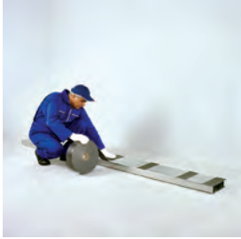
اجرای نوار عایق بر روی استاداها
