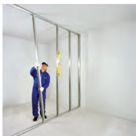
اتصال استاد به دیوار بنایی با اجرای استاداها (به صورت شاقولی) رول پلاک
