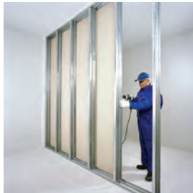
اجرای پانل‌ها در یک طرف دیوار
