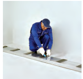
برش نوارهای عایق
