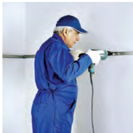
نصب سازه تراز باربر (فاصله پیچ‌ها بر روی دیوار سنتی ۳۰ و بر روی دیوار درای وال هر ۶۰ سانتی‌متر می‌باشد)
