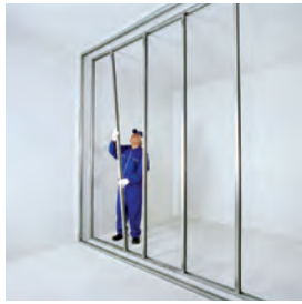
اجرای ردیف اول استاداها
