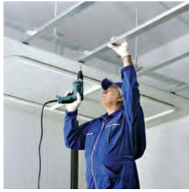
اتصال پانل به زیرسازی توسط پیچ کناف (فاصله پیچ‌ها از یکدیگر ۱۷ سانتی‌متر)
