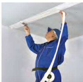
درزگیری و ماستیک توسط پودرهای مخصوص و نوار درزگیری
