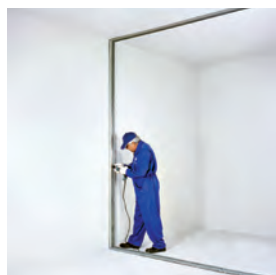
نصب استاد بر روی ساختار جانبی
