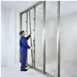
اجرای ردیف دوم استاداها
