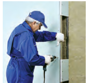
اجرای پانل ها در طرف دیگر دیوار
