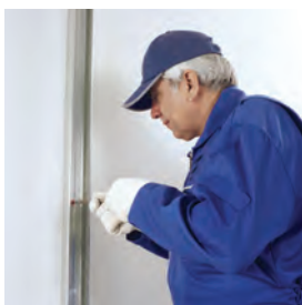
اتصال استاد به دیوار بنایی با اجرای استاداها (به صورت شاقولی) رول پلاک
