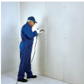
اجرای لایه دوم پانل‌ها
