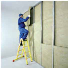
اجرای عایق پشم معدنی
