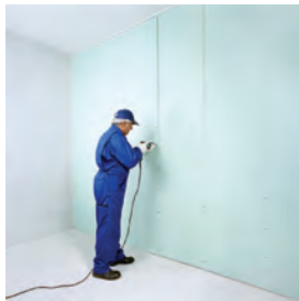
اجرای لایه دوم پانل ها
