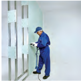
اجرای پانل ها در یک طرف دیوار
