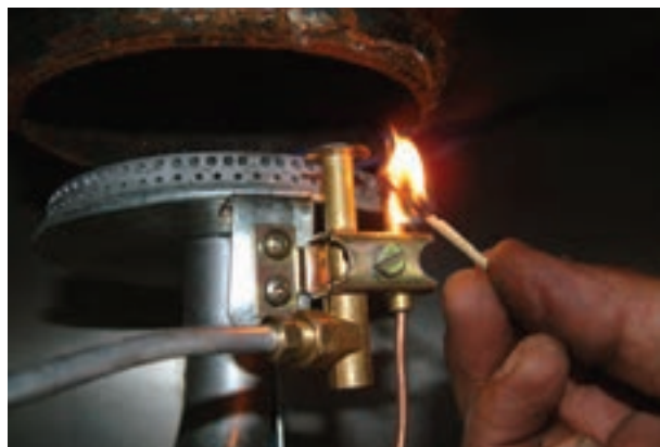
شکل ۱-۱۰۵ مشتعل کردن شمعک به وسیله‌ی شعله‌ی کبریت
