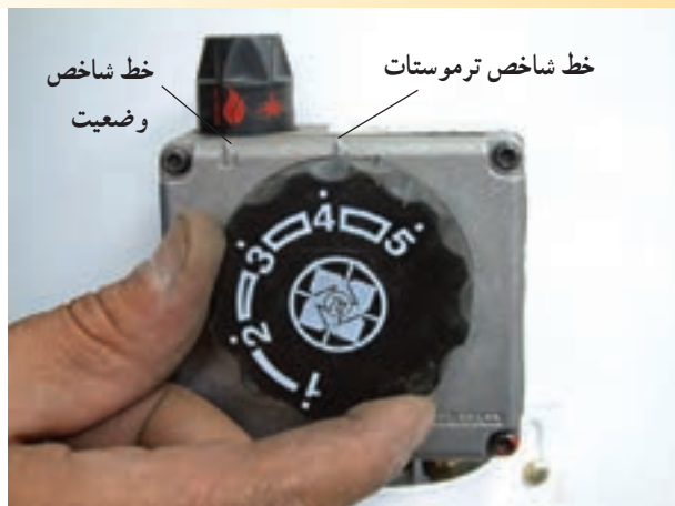
شکل ۱۱۰- تغییر کلید تنظیم دما (ترموسات)
