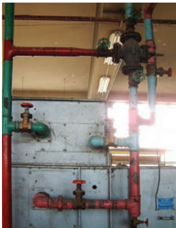
شکل ۲-۸۳ – مورد استفاده‌ی شیر فلکه در تهویه‌ی مطبوع
