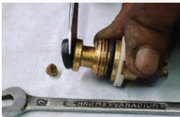
شکل ۲-۶۳- تعویض واشر
