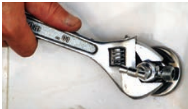
شکل ۱۴۴-۲- سفت کردن شیر پیسوار با آچار فرانسه
