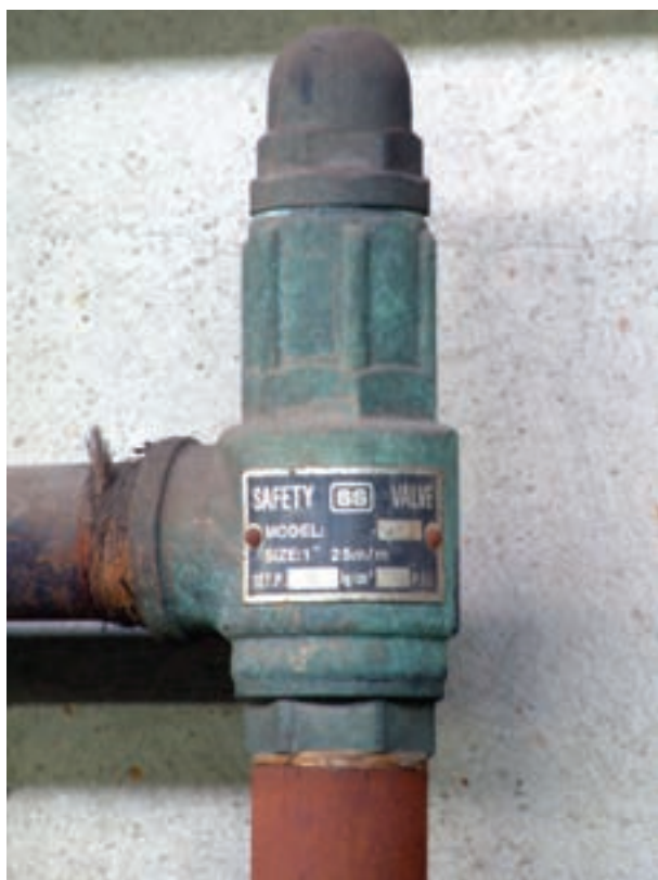
شکل ۱۰۶-۲ شیر اطمینان حساس در برابر فشار
