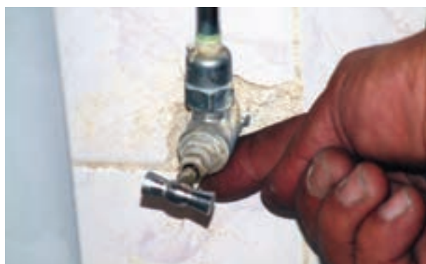
شکل ۱۴۷-۲- کنترل نشت آب از محل اتصال
