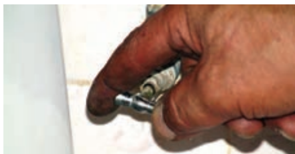
شکل ۱۴۶-۲- عمل هواگیری
