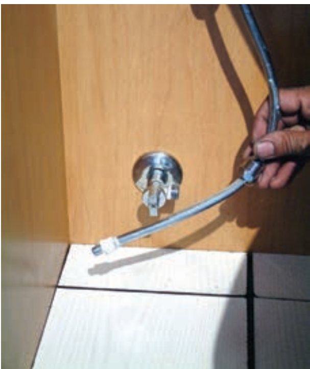
شکل ۲۵۵-۳- خمکاری لوله‌ی پیسوار
