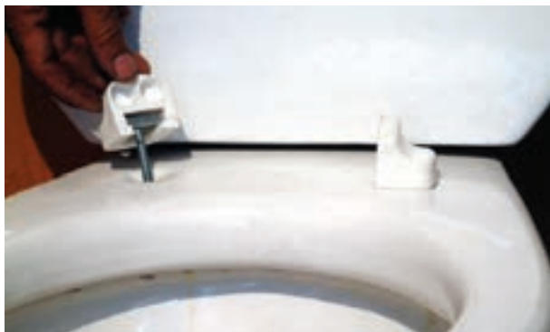
شکل ۲۵۳-۳- اتصال بست‌های نگهدارنده به توالت فرنگی
