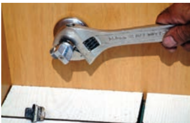
شکل ۲۵۴-۳- سفت کردن شیر پیسوار
