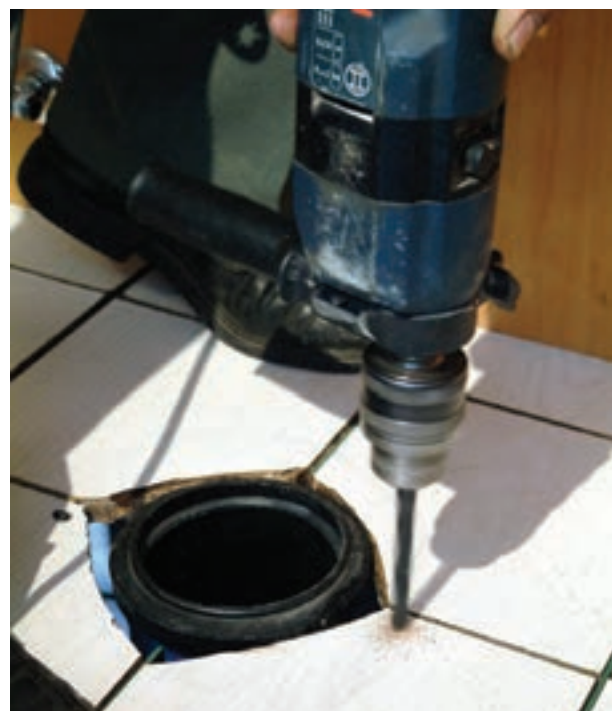
شکل ۲۴۶-۳- سوراخ‌کاری محل‌های علامت‌گذاری شده
