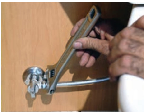
شکل ۳-۲۵۶- سفت کردن مهره‌ی شیر پیسوار
