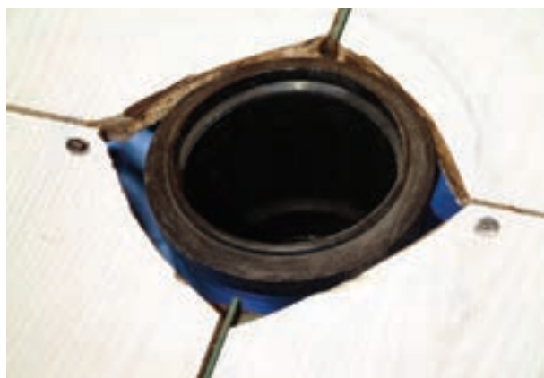
شکل ۲۴۴-۳- قراردادن بوگیر در داخل زانویی
