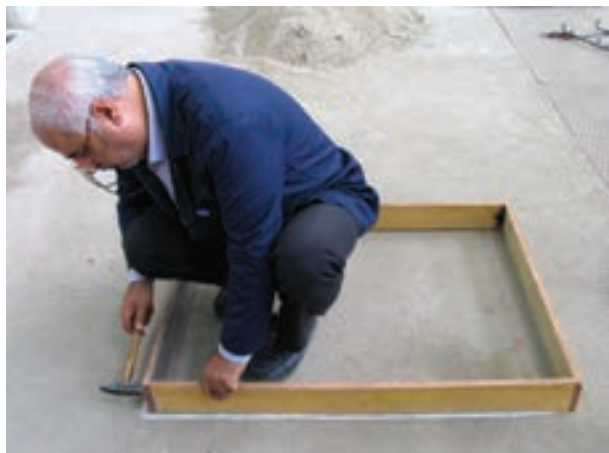
شکل ۴-۱- قالب بندی فونداسیون
