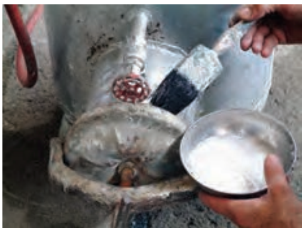
شکل ۲-۳۹- کنترل نشتی گاز
