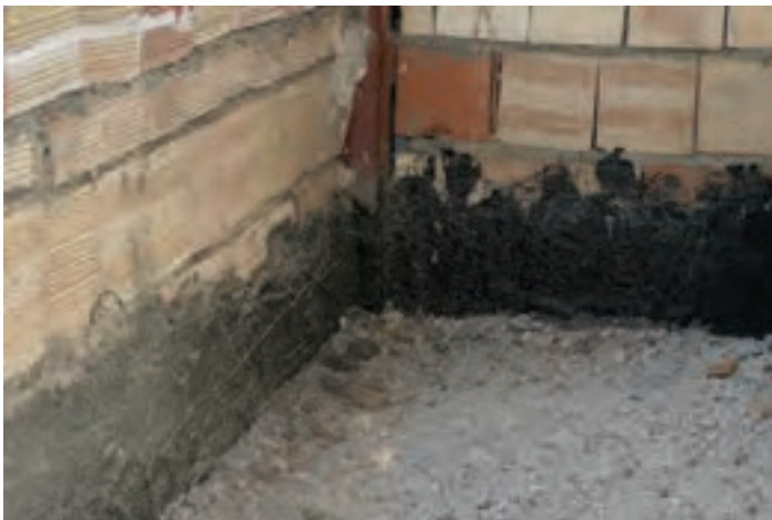
تصویر ۱۶ - عایق کاری کف سرویس بهداشتی
