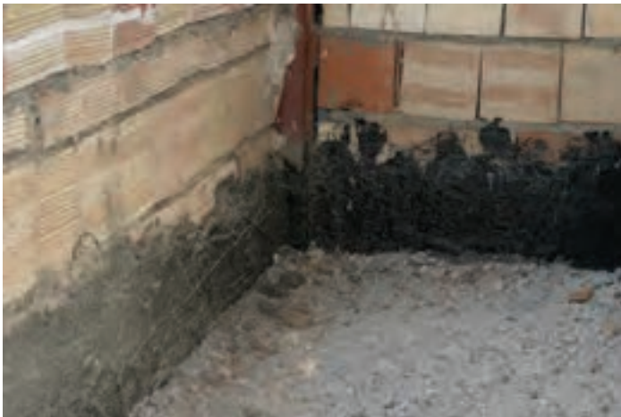
تصویر ۱۶ - عایق کاری کف سرویس بهداشتی
