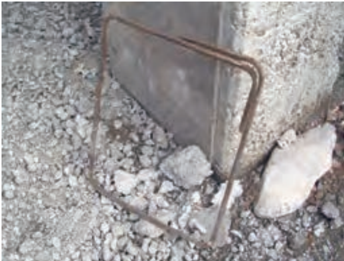
تصویر ۷ - نمونه‌ی یک خاموت
