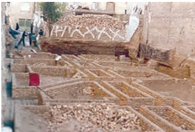
تصویر ۵ - قالب بندی آجری بی ساختمان
