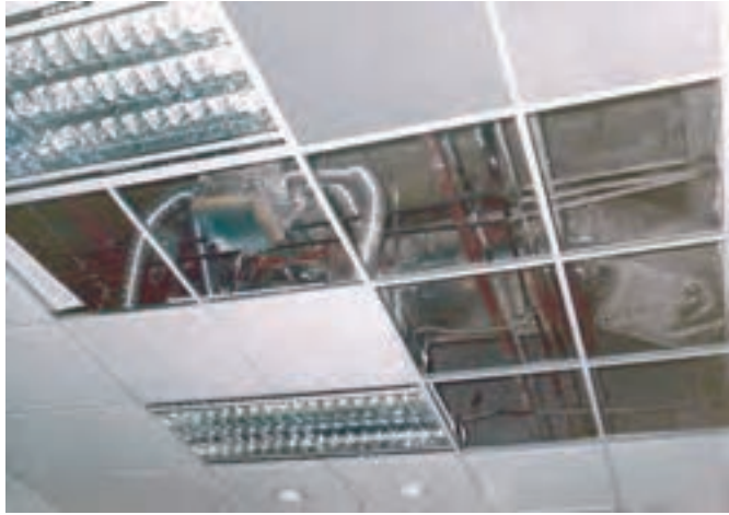
تصویر ۲۰ - زیر سازی سقف کاذب
