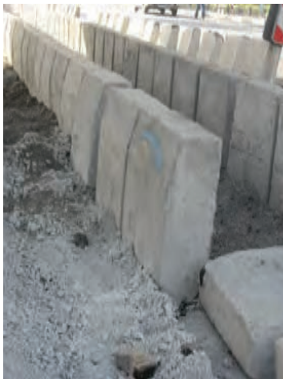
تصویر ۱۵ - قطعات پیش ساخته‌ی بتنی جهت جدول سازی کنار خیابان
