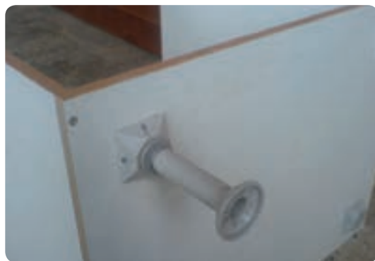
شکل ۱۱۵-۶ پایه نصب شده زیر کابینت
