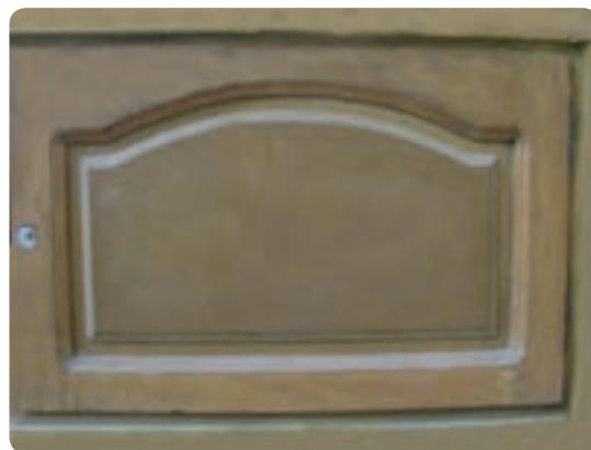
شکل ۶-۸۷ در قاب و تنکه‌ای کابینت
