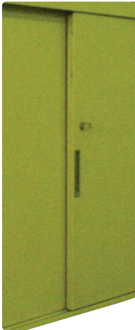
شکل ۶-۳۰ در کشویی با دستگیره توکار
