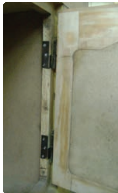
شکل ۶-۸۸ در قاب تنکه‌ای با لولای قابل‌مهم‌ای
