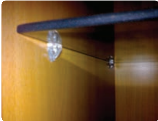
شکل ۶-۷۳ طبقه با زیر سری مناسب
