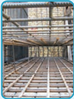
شکل ۱۵-۱- فولاد در بتن
