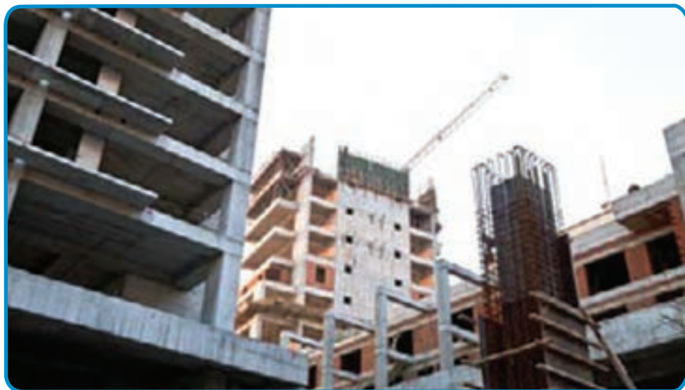
شکل ۱-۲- سازه‌های بتن آرمه
