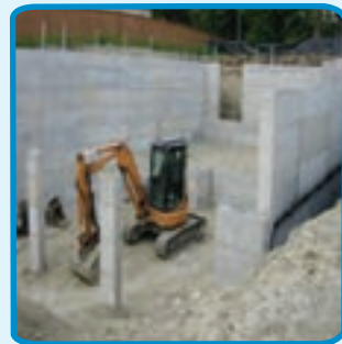
شکل ۲۱-۲- دیوار باربر
