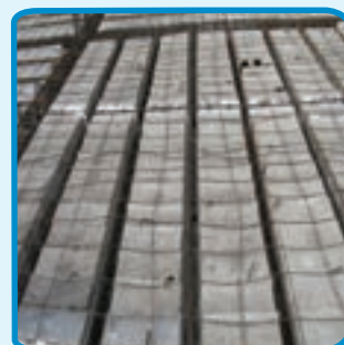
شکل ۲-۲۸- سقف تیرچه و بلوک
