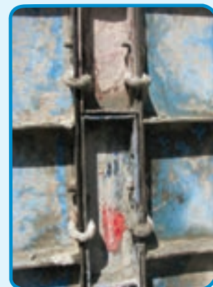
شکل ۱۳-۳- پشت بند قالب
