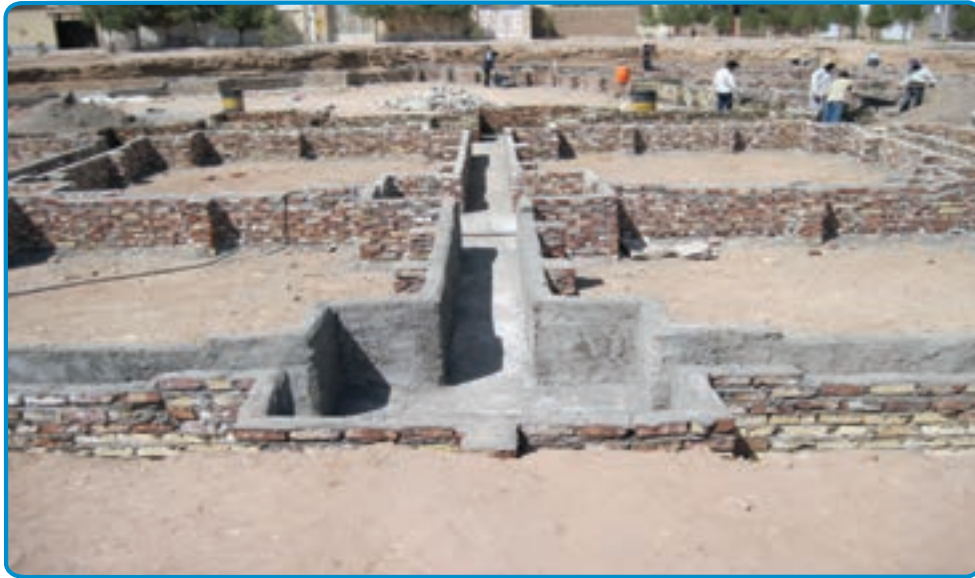
شکل ۳-۲۹- قالب آجری برای اجرای پی
