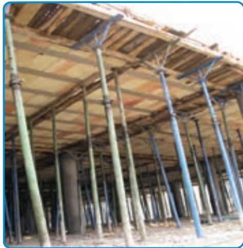
شکل ۳-۲۱- استفاده از شمع‌های فلزی جهت نگهداری قالب‌ها
