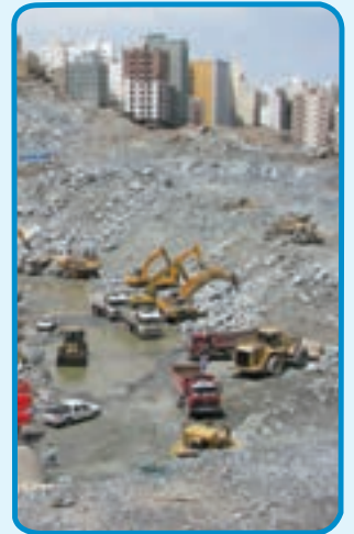
شکل ۳-۷- گودبرداری در زمین‌های نامحدود
