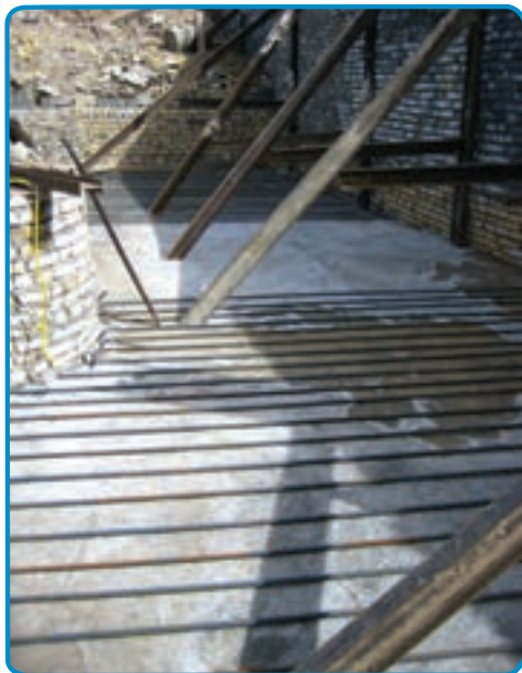
شکل ۳-۴۶- میلگرد طولی کف پی
