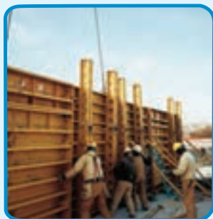
شکل ۳-۳۶- قالب فایبر گلاس برای اجرای دیوار بتنی
