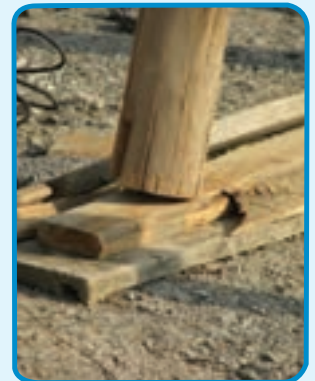
شکل ۳-۲۵- استفاده از گوه جهت تنظیم ارتفاع
