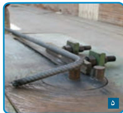
شکل ۶۴-۳- خم کردن میلگرد
