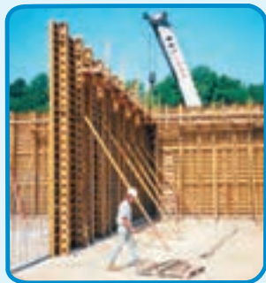
شکل ۱۹-۳- اجرای دیوار بتنی فایبر گلاس برای
