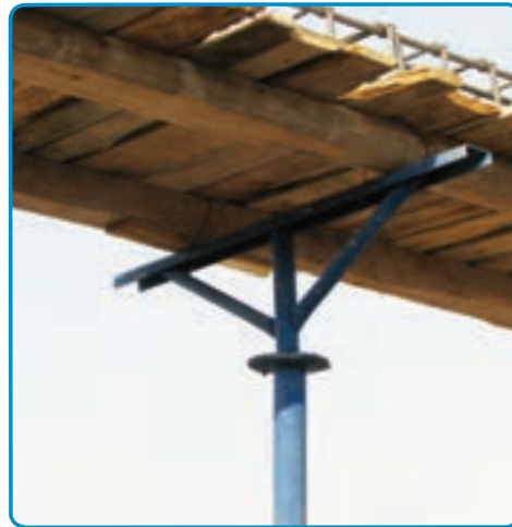
شکل ۳-۲۱- استفاده از شمع‌های فلزی جهت نگهداری قالب‌ها
