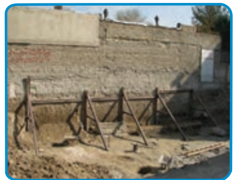
شکل ۳-۴- گودبرداری در زمین‌های محدود در تصاویر بالا اجرای سازه‌های نگهدارنده برای محافظت از ریزش ساختمان‌های مجاور نشان داده شده است
