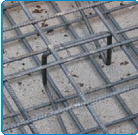
شکل ۳-۵۳- استفاده از خرک در میلگرد گذاری پی
