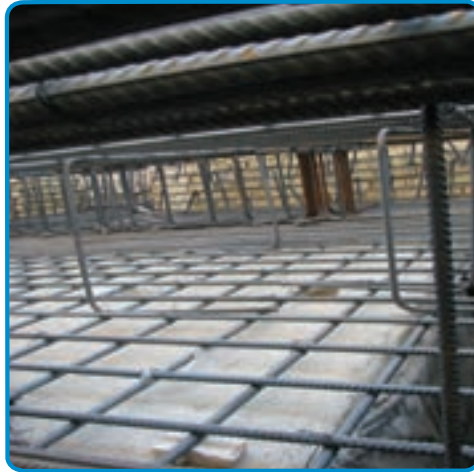
شکل ۳-۵۳- استفاده از خرک در میلگرد گذاری پی
