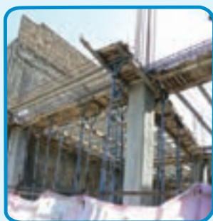
شکل ۳-۳۹- استفاده از قالب چوبی برای اجرای تیر
