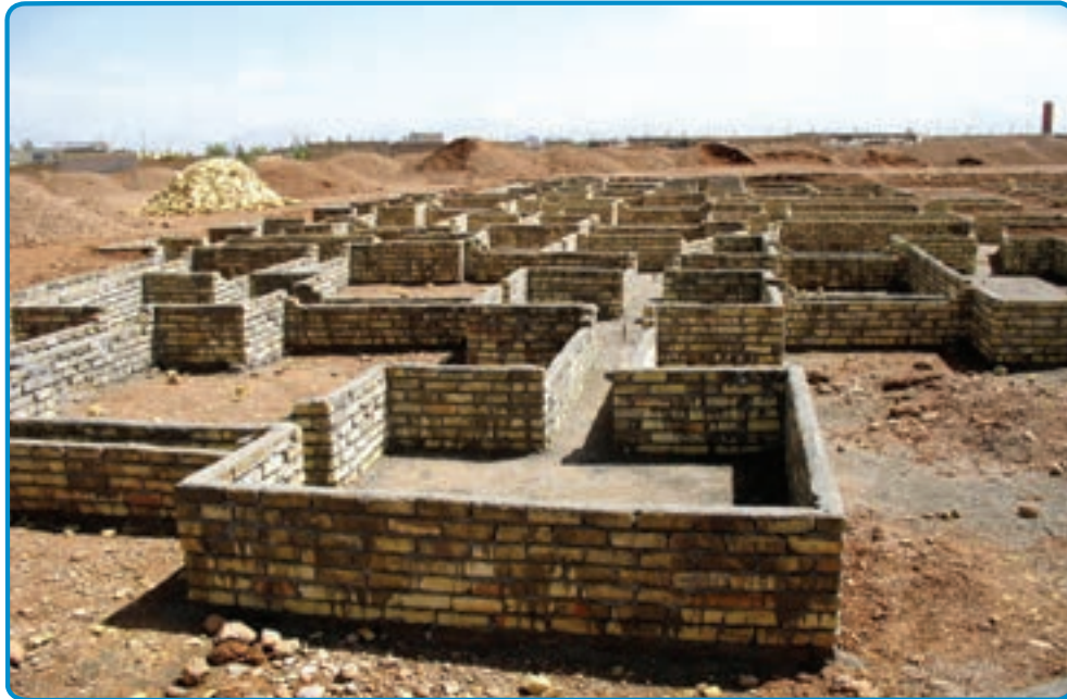
شکل ۱۵-۳- استفاده از قالب آجری برای اجرای پی
