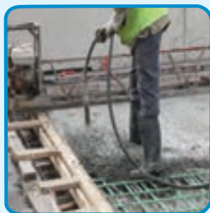
شکل ۱۴-۳- ویبراتور یا لرزاننده بتن داخل قالب
