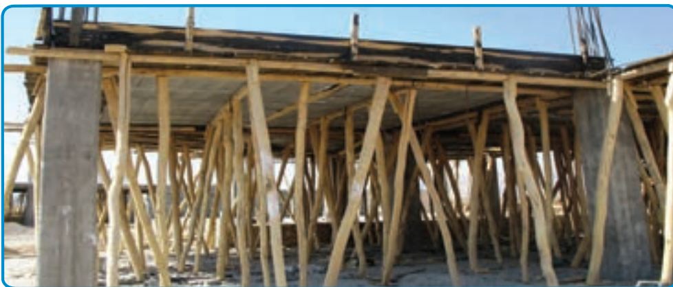
شکل ۳-۲۴- استفاده از شمع‌های چوبی جهت نگهداری قالب‌ها
