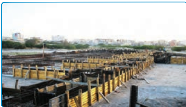
شکل ۳-۲۷- قالب چوبی برای اجرای پی
