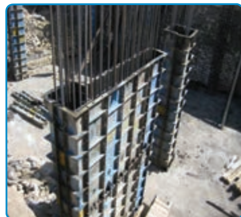
شکل ۳-۳۵- قالب فلزی برای اجرای دیوار بتنی
