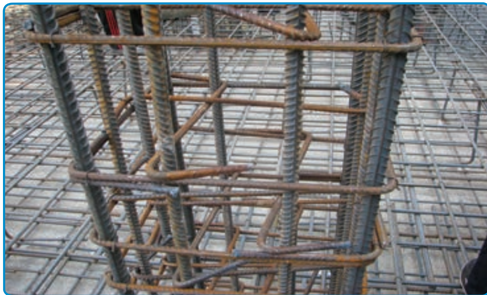
شکل ۵۰-۳- کاربرد سنجاقک در میلگرد گذاری ستون
