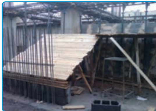
شکل ۳-۴۱- استفاده از قالب چوبی برای اجرای پله بتنی
