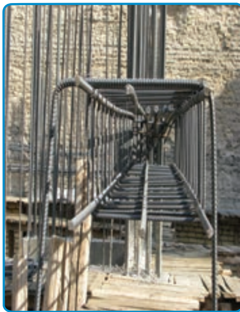
شکل ۳-۴۵- میلگرد طولی در تیر
