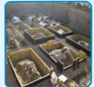
شکل ۳-۳۱- قالب فایبرگلاس برای اجرای پی
