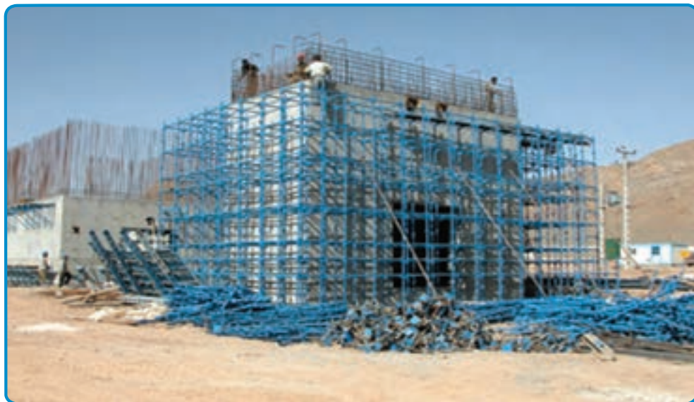
شکل ۳-۲۶- داربست فلزی
