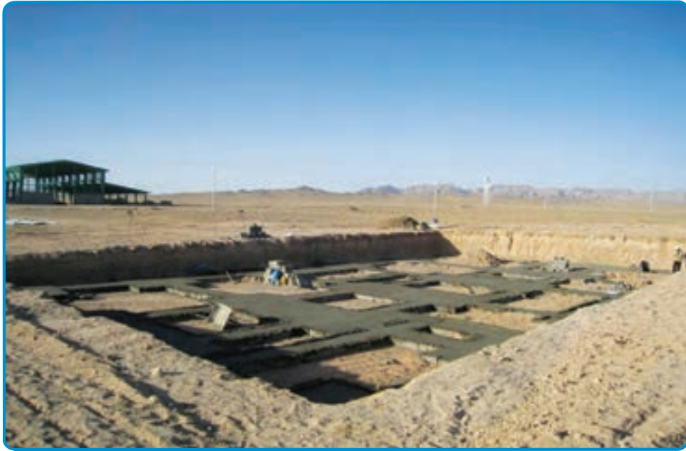
شکل ۳-۶- گودبرداری در زمین‌های نامحدود
