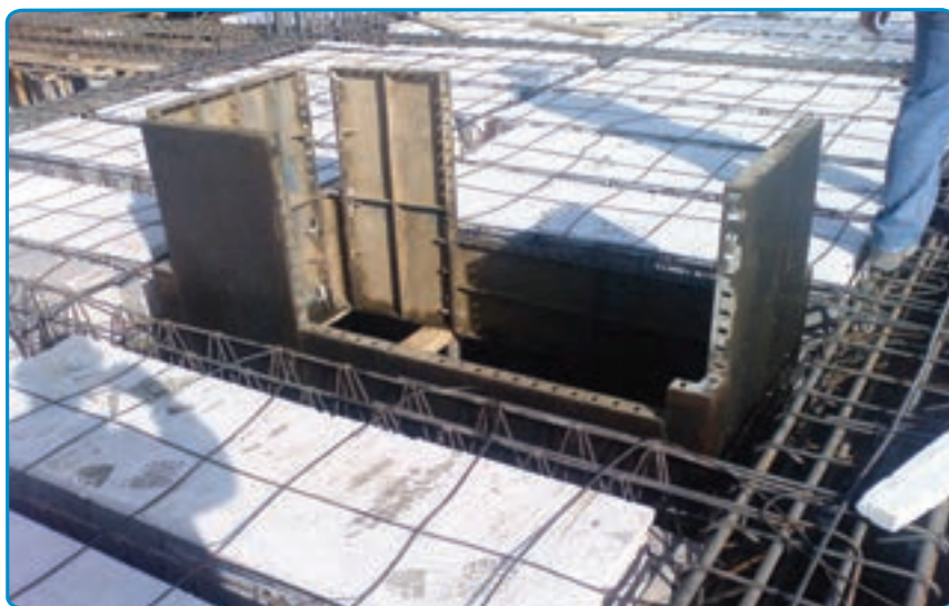
شکل ۳۵-۷- تکمیل قالب بندی
