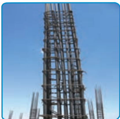
شکل ۱۹-۷- کار گذاشتن میلگردهای انتظار ستون، در فونداسیون
