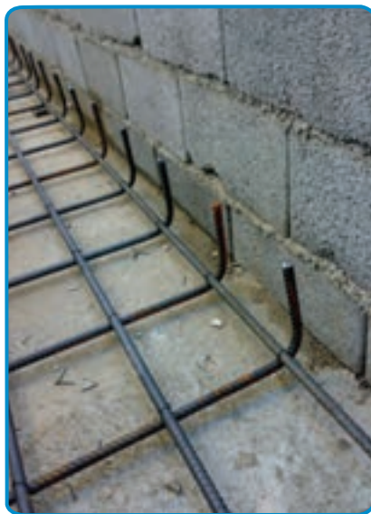
شکل ۱۰-۷- رعایت پوشش بتن در کف و بدنه
