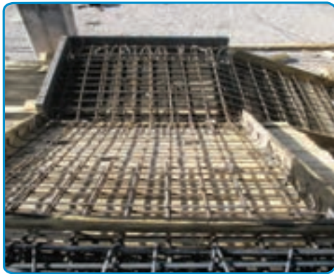
شکل ۳۷-۷- اجرای میلگردهای دال پله
