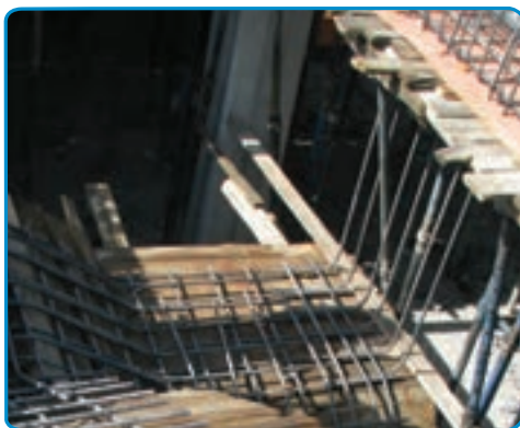
شکل ۴۱-۷- اجرای میلگردهای دال پله
