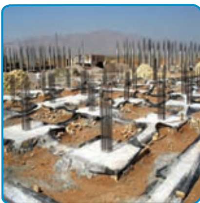
شکل ۱۷-۷- اجرای خاموت و سنجاقک
