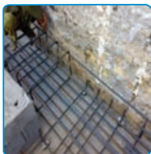
شکل ۱۲-۷ میلگردگذاری شبکه بالای
