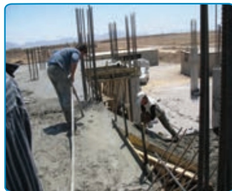
شکل ۴۲-۷- بتن ریزی دال پله
