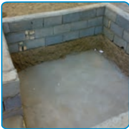
شکل ۱-۷- آماده سازی کف پی
