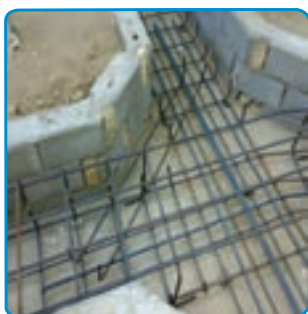
شکل ۱۳-۷ قرار دادن میلگردهای تقویتی پخها
