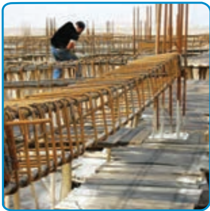
شکل ۷-۲۴- تنظیم فاصله بین خاموت ها
