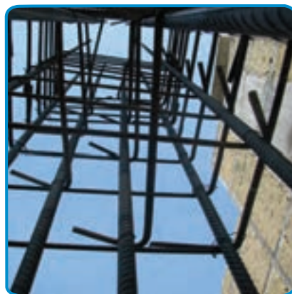
شکل ۱۹-۷- کار گذاشتن میلگردهای انتظار ستون، در فونداسیون
