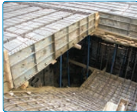
شکل ۴۰-۷- اجرای میلگردهای دال پله
