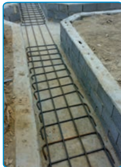
شکل ۸-۷- چیندن میلگردهای طولی و عرضی
