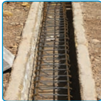
شکل ۵-۷- اجرای میلگرد شناژها
