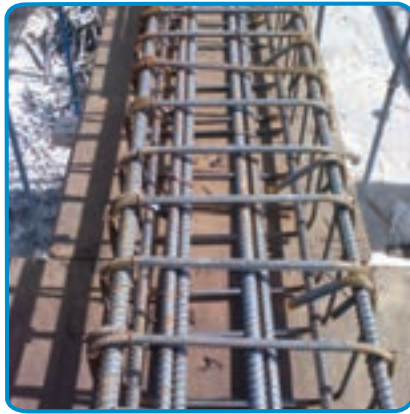
شکل ۷-۲۵- بستن خاموت ها با مفتول
