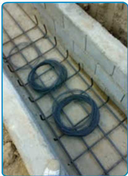
شکل ۹-۷- بهم بستن میلگردها
