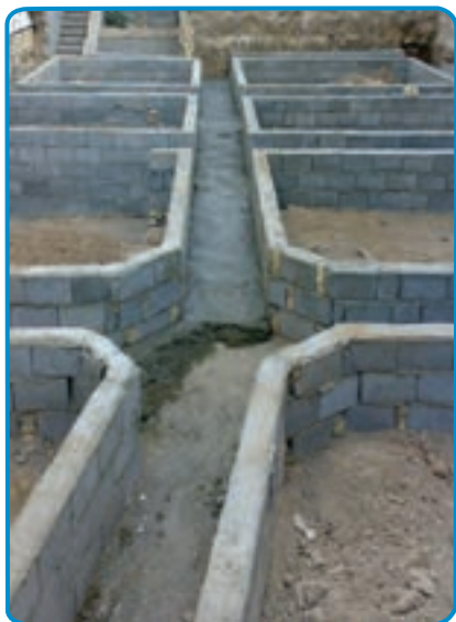
شکل ۶-۷- آماده سازی کف پی
