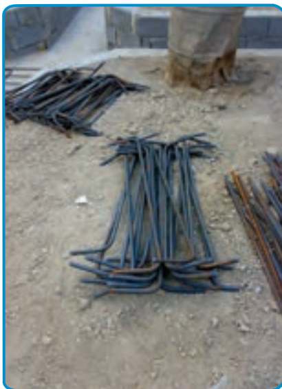
شکل ۷-۷- آماده کردن میلگردهای طولی و عرضی
