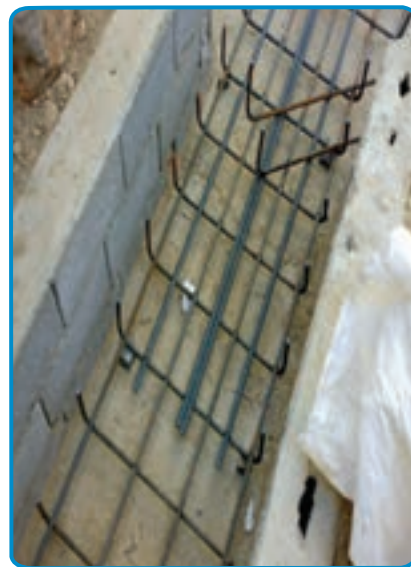
شکل ۱۱-۷- قرار دادن میلگردهای تقویتی
