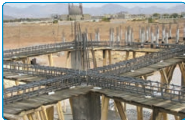
شکل ۷-۲۷- رعایت فاصله پوشش بتنی در کف
