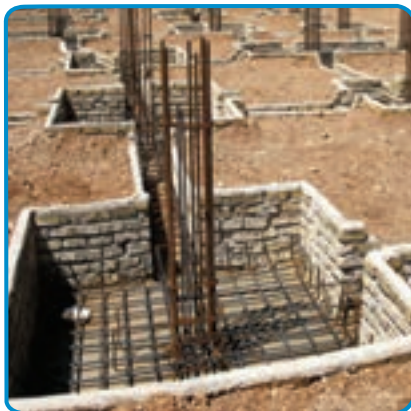
شکل ۴-۷- اجرای میلگردهای ریشه انتظار
