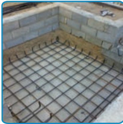
شکل ۲-۷- اجرای میلگرد های طولی و عرضی کف پی
