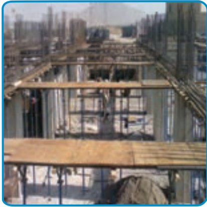
شکل ۷-۲۱- قالب بندی تیرها
