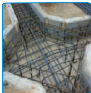
شکل ۱۴-۷ تکمیل میلگردگذاری محل اتصال ستون
