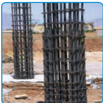
شکل ۱۶-۷- بتن ریزی ستون
