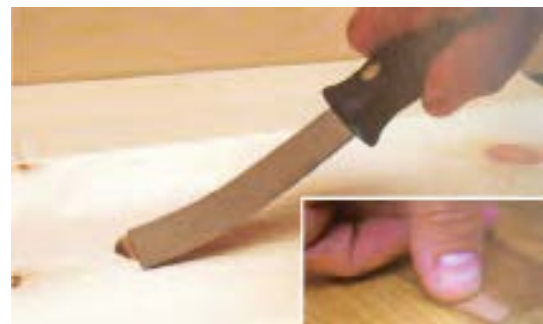
شکل ۱۷-۴. فقط باید ترک‌ها، زدگی‌ها و... را بتونه کشید.
