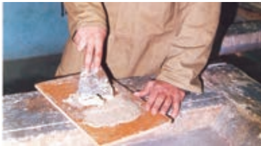
شکل ۹-۴- بتونه روی تخته بتونه تهیه و سافته می شود.
