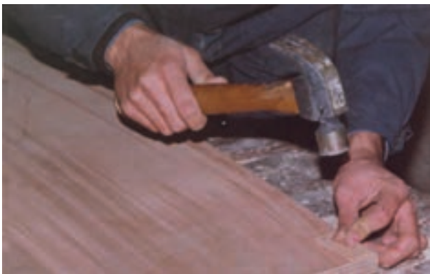
شکل ۱۱-۳۳- میخ کردن موقت صفحه به کلاف، به وسیله میخ و فیبر.
