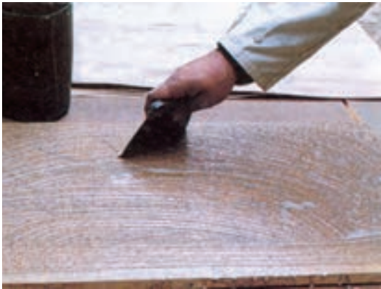
شکل ۶-۱۶- چسب را به وسیله‌ی شانه، روی صفحه‌ی مصنوعی پخش کنید.
