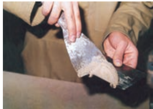
شکل ۸-۴- کاربرد لیسه و کاردک هنگام بتونه کاری.
