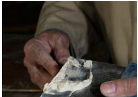
شکل ۱۵-۴. هر بار باید مقدار کمی بتونه روی لیسه قرار داد.
