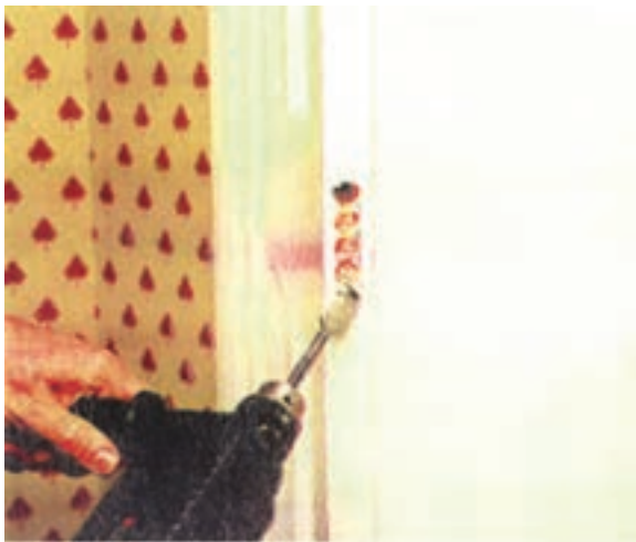
شکل ۱۰-۴۵ - تفلیهی ممل قفل با دریل.
