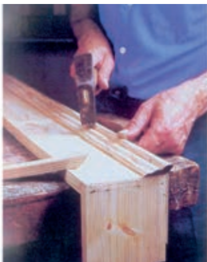
شکل ۱۳-۱۰- نصب زهوار با میخ.
