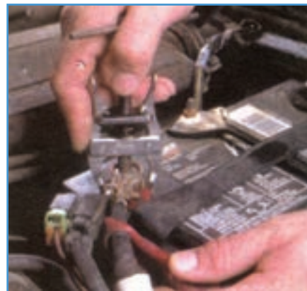
شکل ۸-۶- باز کردن بست مثبت باتری
