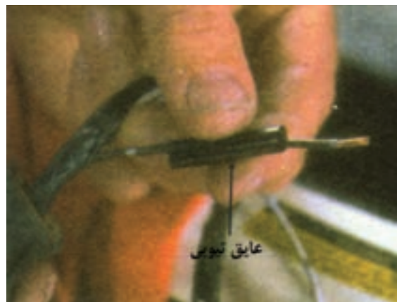
شکل ۶۳-۶- وارد کردن سیم به داخل عایق تیوبی
