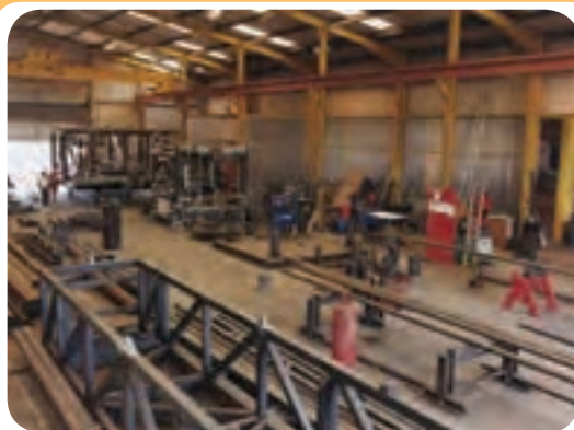
الف) کارگاه ساخت سازه‌های ساختمانی
