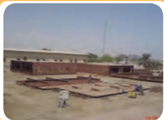
د) کارگاه ساخت اسکلت فلزی ساختمان
