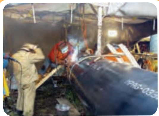
ن) کارگاه ساخت خط لوله
