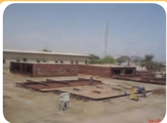
د) کارگاه ساخت اسکلت فلزی ساختمان
