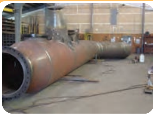
ج) کارگاه ساخت تجهیزات صنعتی
