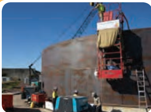
م) کارگاه ساخت مخازن ذخیره
