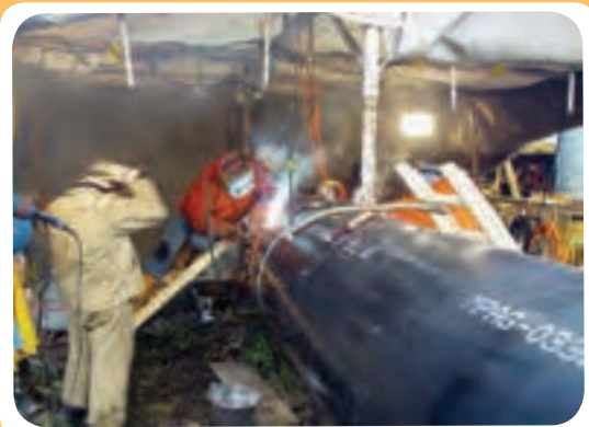
ن) کارگاه ساخت خط لوله
