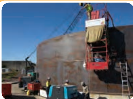
م) کارگاه ساخت مخازن ذخیره
