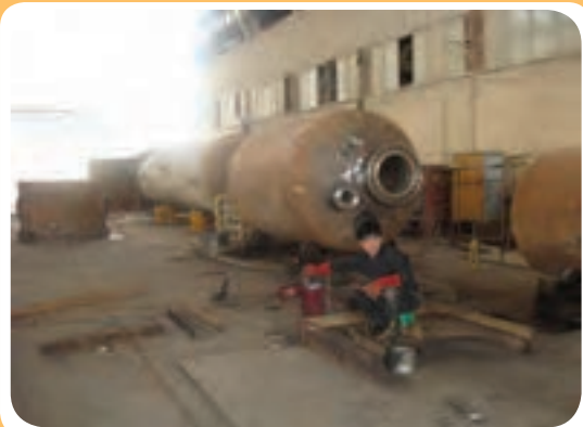
ب) کارگاه ساخت مخازن تحت فشار
