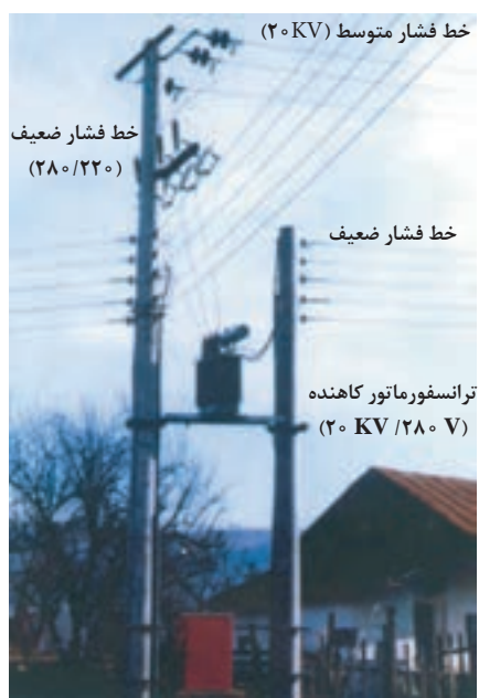
شکل ۲۷- خطوط فشاری متوسط و ضعیف هوایی برق
