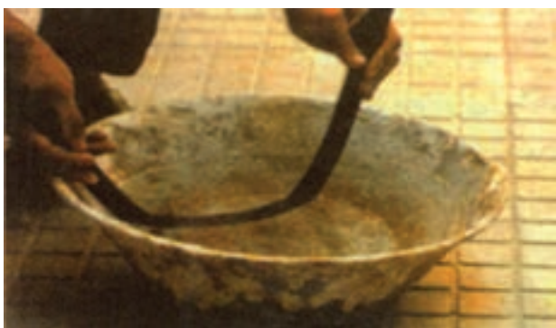
شکل ۴-۴۵- سرد کردن لوله پس از خم‌کاری
