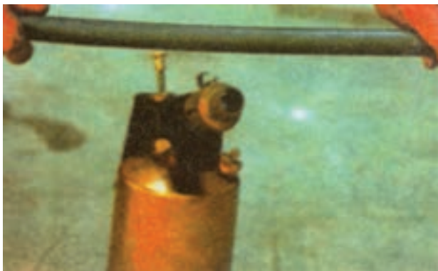
شکل ۴-۴۳- حرارت دادن لوله‌ی PVC
