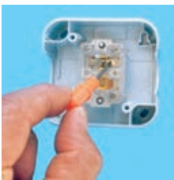
د - برقراری اتصال پلاتین با کنتاکت غیرمشترک ۲
