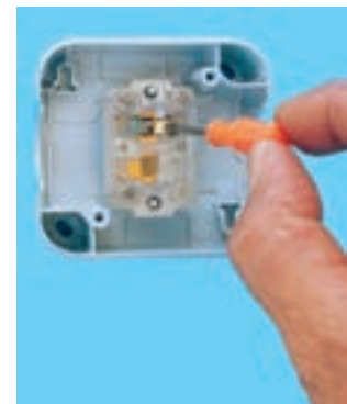
ج - برقراری اتصال پلاتین با کنتاکت غیرمشترک ۱
