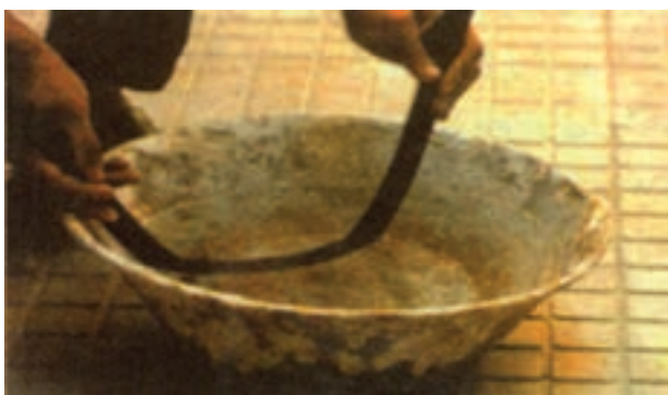
شکل ۴-۴۵ - سرد کردن لوله پس از خم‌کاری
