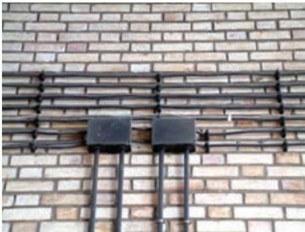
شکل ۵-۵۷- کابل‌کشی روی دیوار
