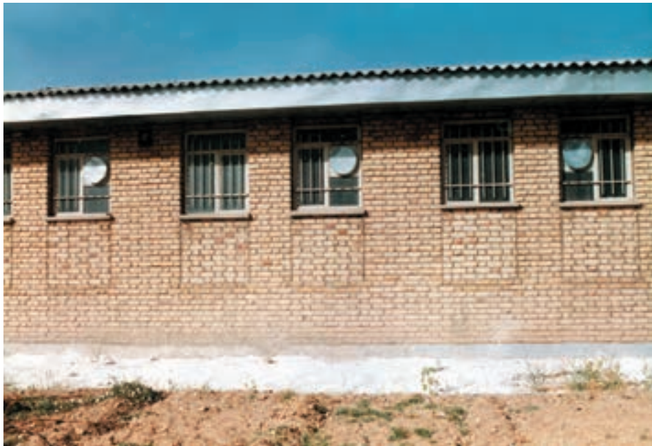
تصویر نمای خارجی یک جایگاه پنجره‌دار
