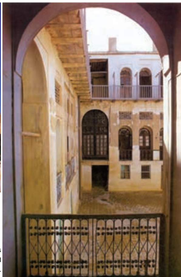
تصویر ۱۲-۶- سایه بان در پنجره ها و استفاده از رنگ های روشن در سطوح خارجی بنا - خانه ای در بندر بوشهر
