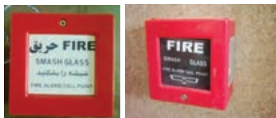
شکل ۱-۲۱ دو نمونه شستی اعلام حریق شیشه‌ای
