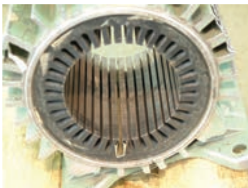
ب - اندازه کردن ابعاد عایق با ابعاد شیار شکل ۲۸-۲ - تنظیم عایق برشمان در شیارهای استاتور
