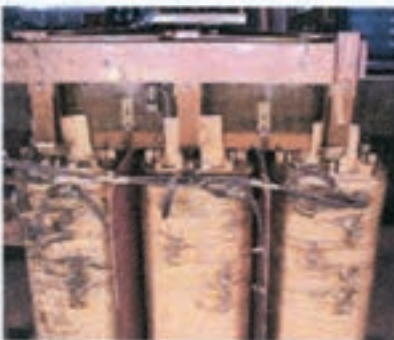
شکل (۳-۲۴) در سیم پیچ های ناسالم یکنواختی رنگ موجود نیست
