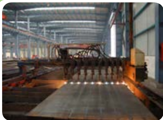
اجرای عملیات برشکاری روی میز برش توسط سیستم برشکاری با ده مشعل بصورت همزمان
