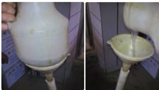
شکل ۱۸-۵- شست‌وشوی مبدل بعد از رسوب‌زدایی
