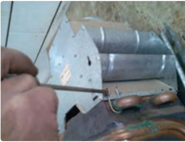
شکل ۶-۱- جدا کردن کلاهک تعدیل از مبدل
