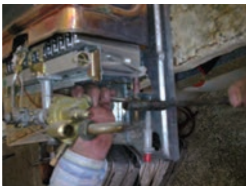
شکل ۸-۱- مبدل گرمایی
